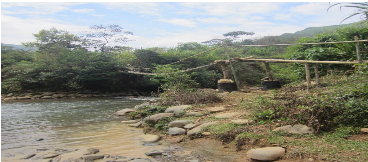
Foto: Fuente propia. Vida de acceso a sede San Juan Bosco y Gabriela Mistral.
