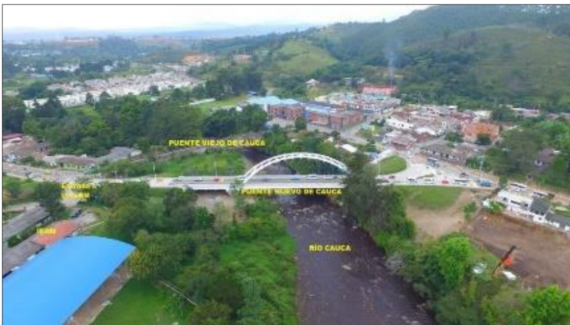
Imagen 1. Nuevo puente sobre el río Cauca, a la izquierda la IEGM.
