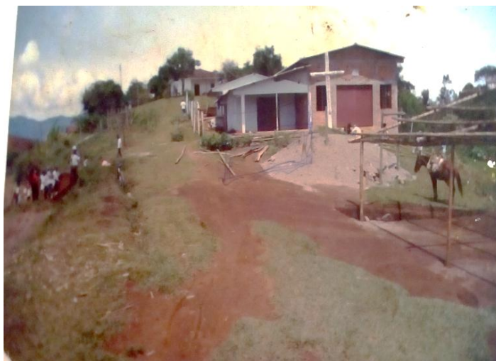
Fotografía 6 Construcción de la escuela capilla. Fuente: Álbum de la maestra Piedad Amparo Calderón.
