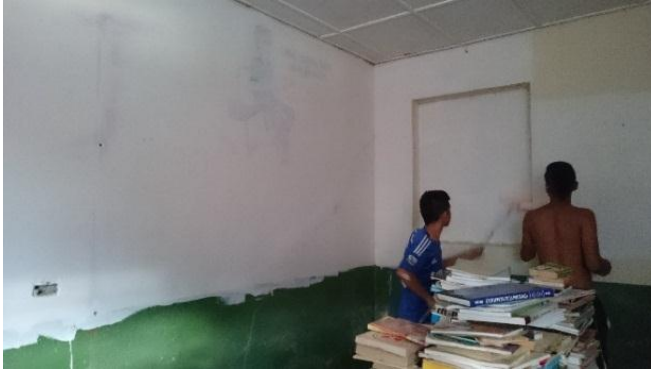
Fotografía 4. Estudiantes trabajando en la adecuación de la Biblioteca.
