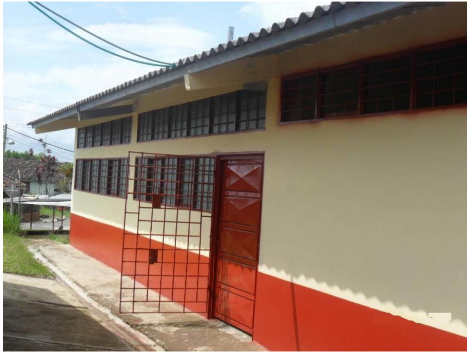
Imagen 0-2: Fachada Sala de Sistemas
