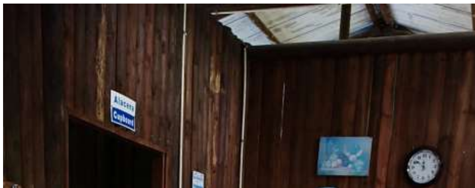
Figura 9. Paredes y techo
