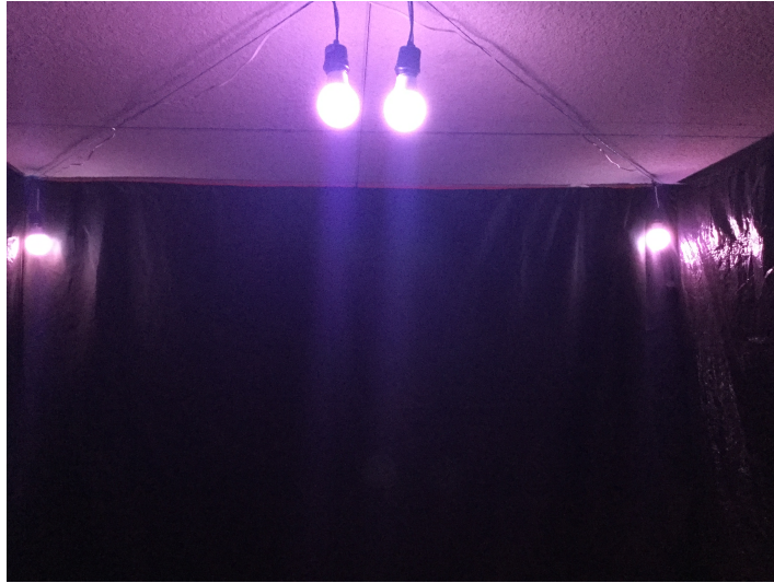
Figura 4.5: Extensión de la red eléctrica sobre el techo del cuarto
