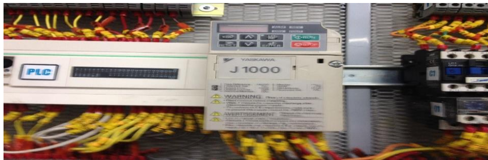
Figura 4.34: VFD que controla la velocidad de giro del motor Baldor
