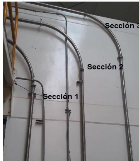
Figura 11 Líneas del sistema neumático previamente implementado.
