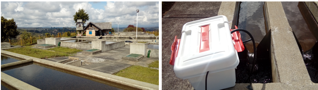
(a) Acueducto Rural de Rionegro. [Fuente: Propia] (b) Monitoreo de las variables cada 15 minutos. [Fuente: Propia]
