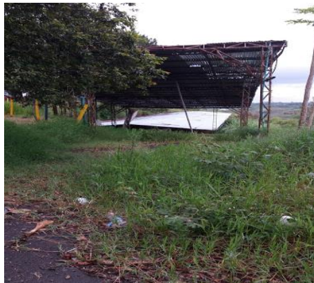
Figura 9. Área de maniobra de vehículos
