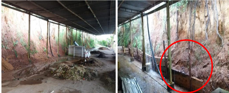
Figura 22. Recuperación del talud
