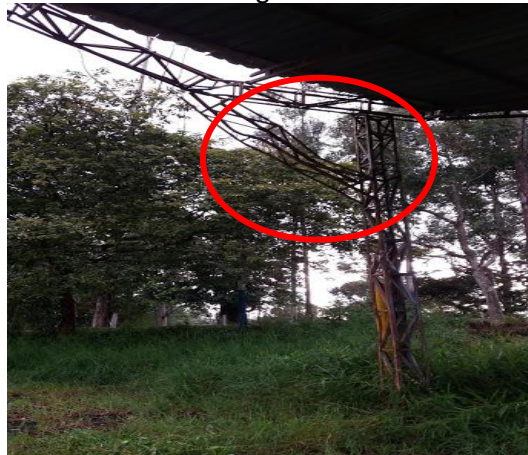
Figura 10. Área de recepción del material orgánico
