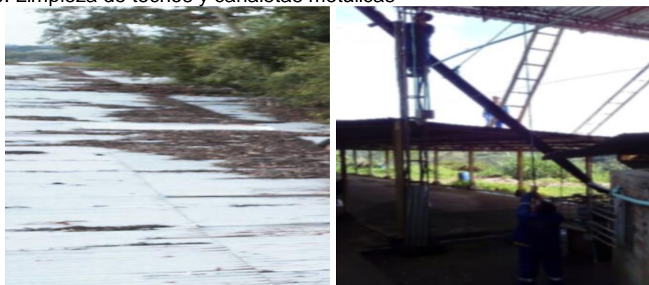
Figura 20. Limpieza de techos y canaletas metálicas
