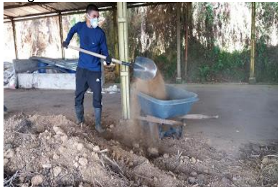
Figura 21. Limpieza y trasiego de materiales
