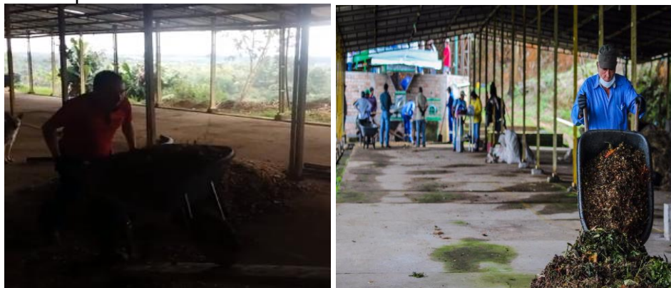
Figura 28. Transporte de material en carretillas
