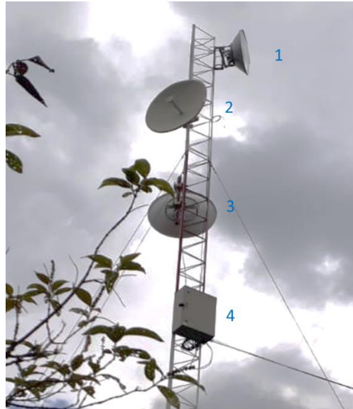
Figura 39. Instalación de antena nodo El Recreo
