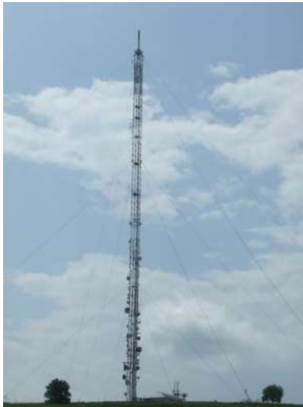
Figura 1.9. Antena monopolo para transmisión de AM
