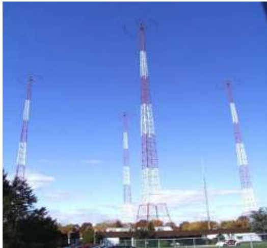
Figura 5. Arreglo de Dipolos \lambda/2 en MW 4
