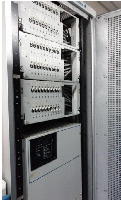
Figura B.20: Equipo de Alimentación – Actividad Descubriendo la central AXE. (Fuente Propia).
