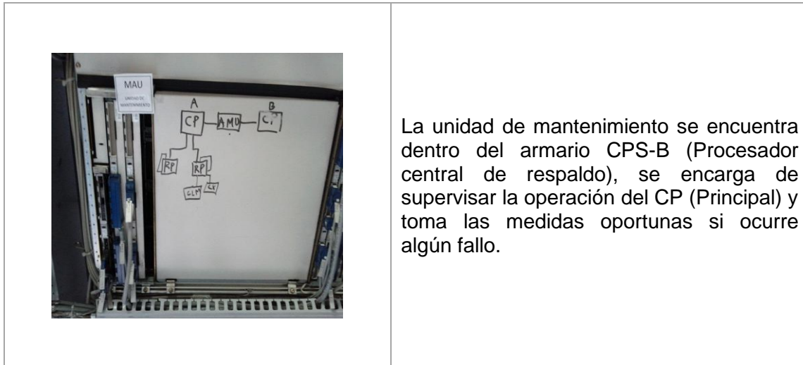
Figura B.17: Unidad de Mantenimiento – Actividad Descubriendo la central AXE. (Fuente Propia).
