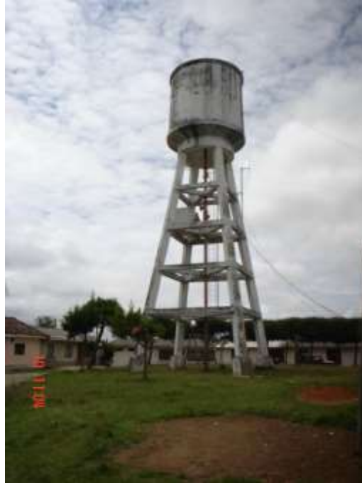
Figura No 11. Tanque Acueducto Municipal
