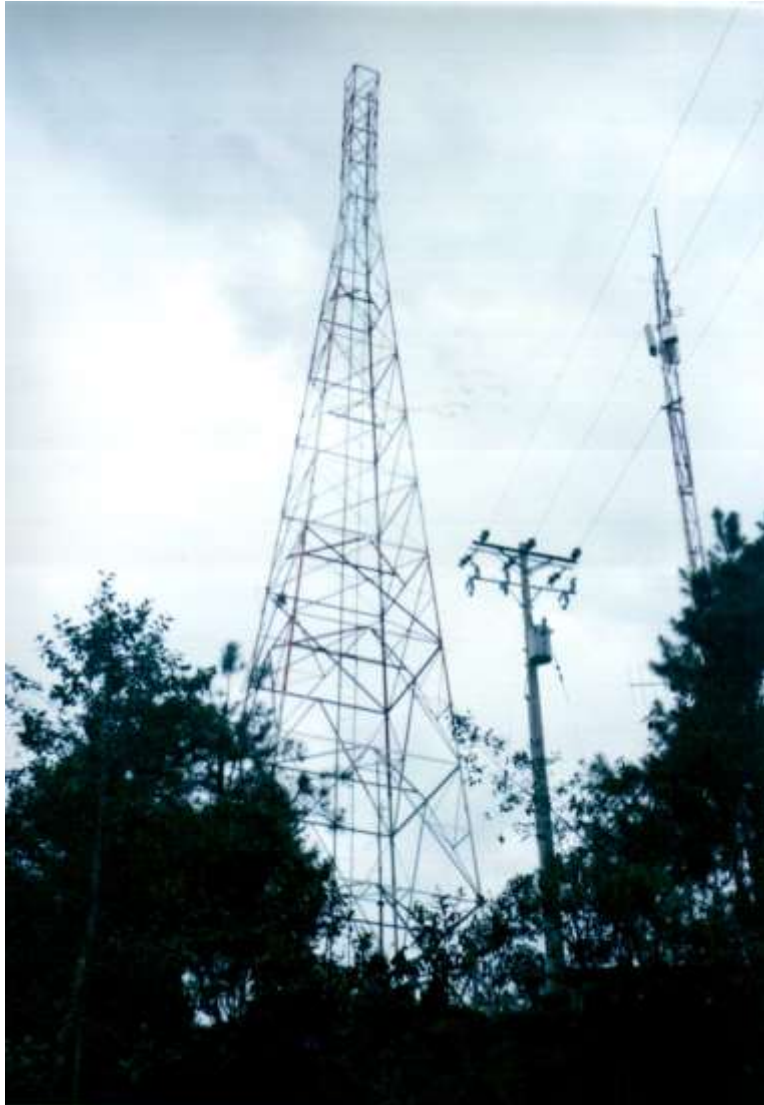
Figura 3.9 Fotografía de la torre de transmisión.
