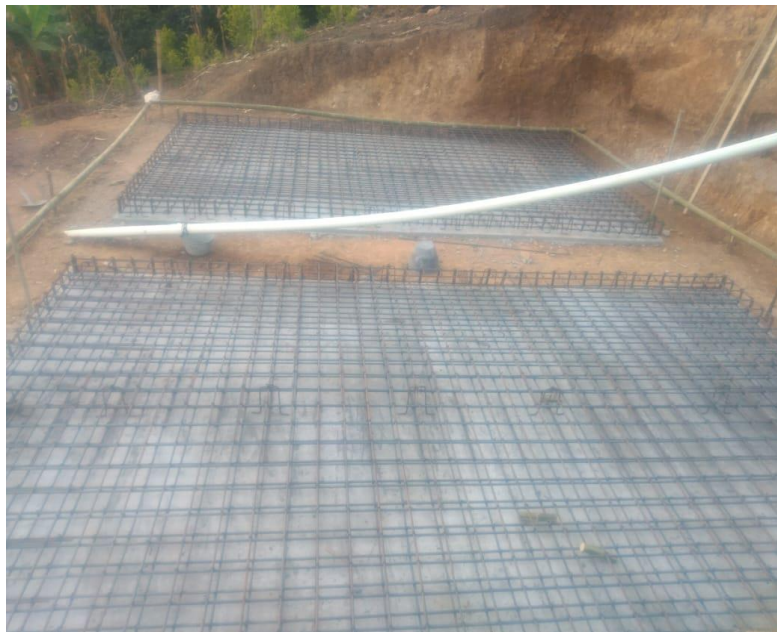
Figura 16: acero de losas principales
