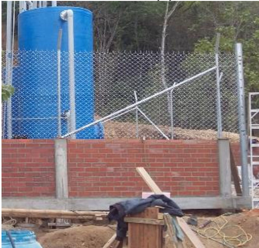
Figura 26. Cerramiento en ladrillo, malla eslabonada, columnas de concreto, cimentación en concreto ciclópeo.
