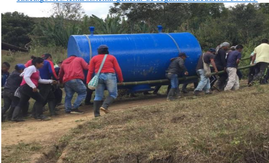
Figura 18: Suministro de sistema de potabilización.
