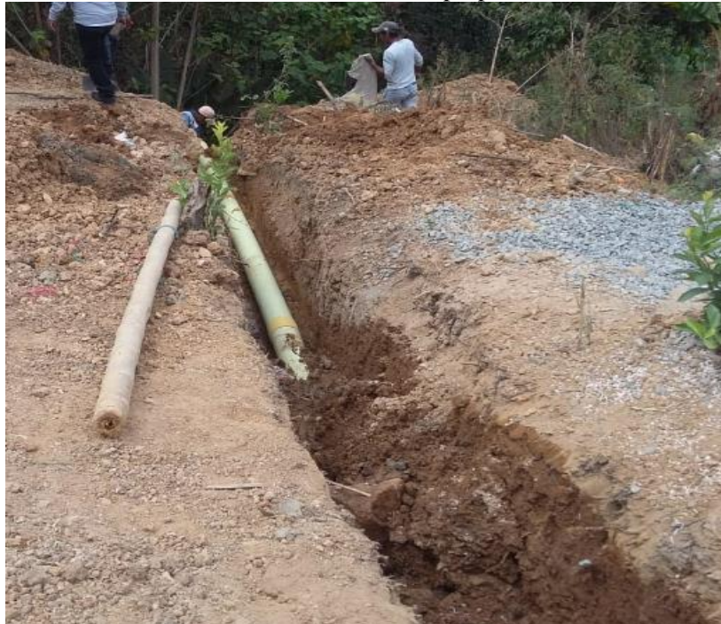
Figura 10: excavación para tuberías de desagüe
