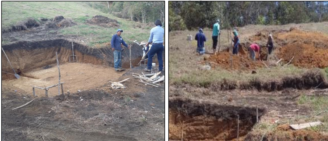
Figura 31. Localización, replanteo y explanación de los sitios de implantación de las unidades de la PTAR SAN CRISTOBAL
