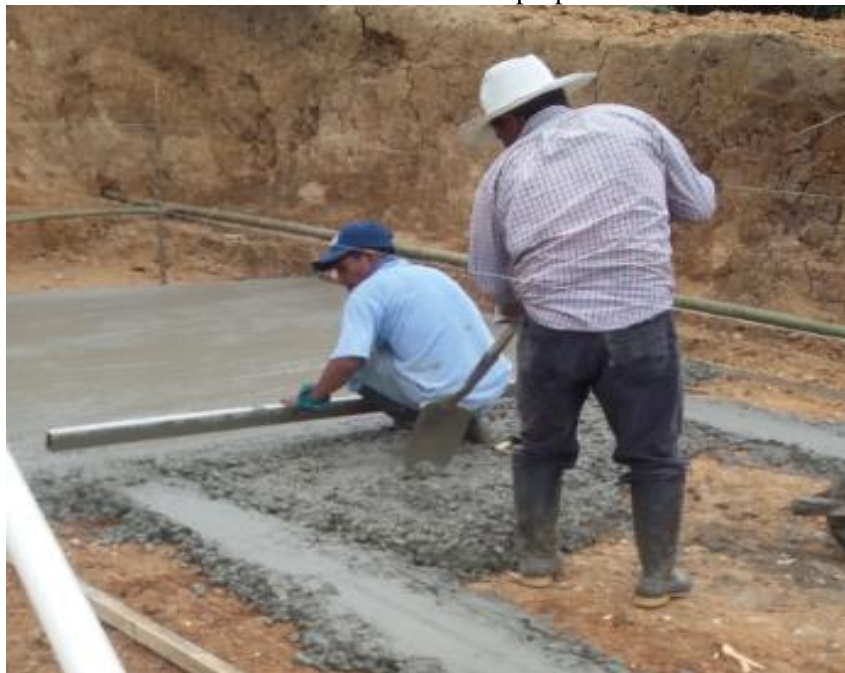
Figura 12: Solado para losas de e: 25cm
