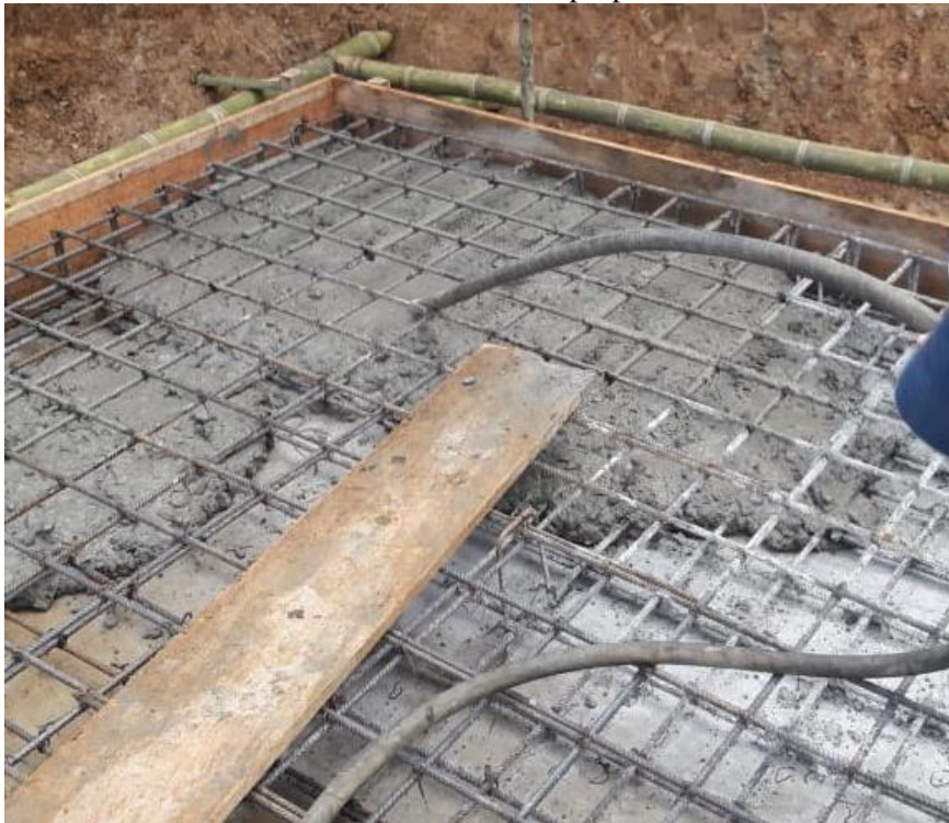
Figura 14. Colocación y vibrado del concreto de las losas de e: 25 cm
