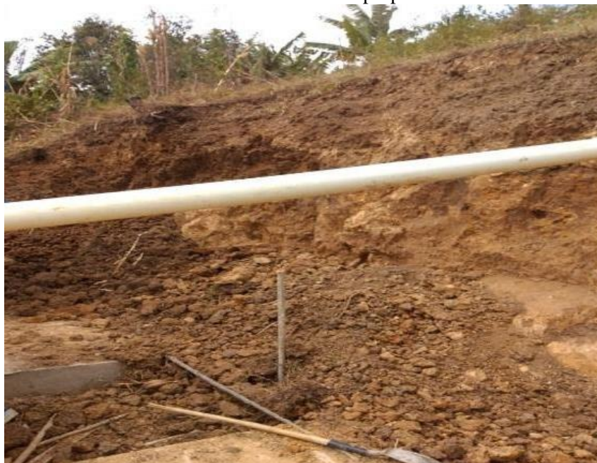
Figura 9 excavación y perfilado de taludes
