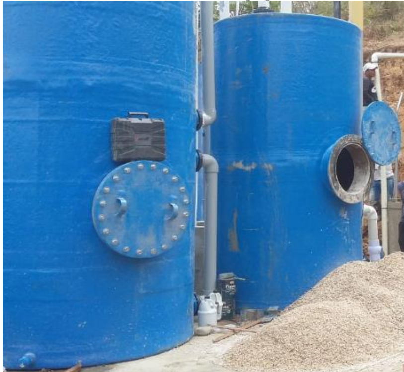
Figura 21. Reemplazo de material filtrante en la unidad de coagulación floculación.
