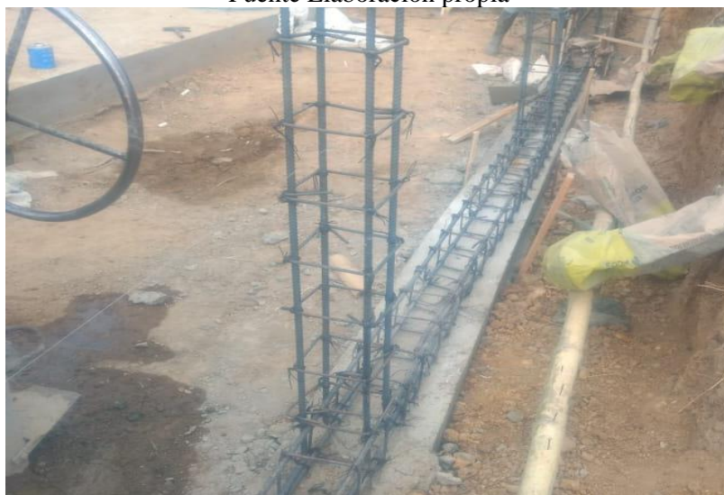
Figura 17: acero de vigas y columnas
