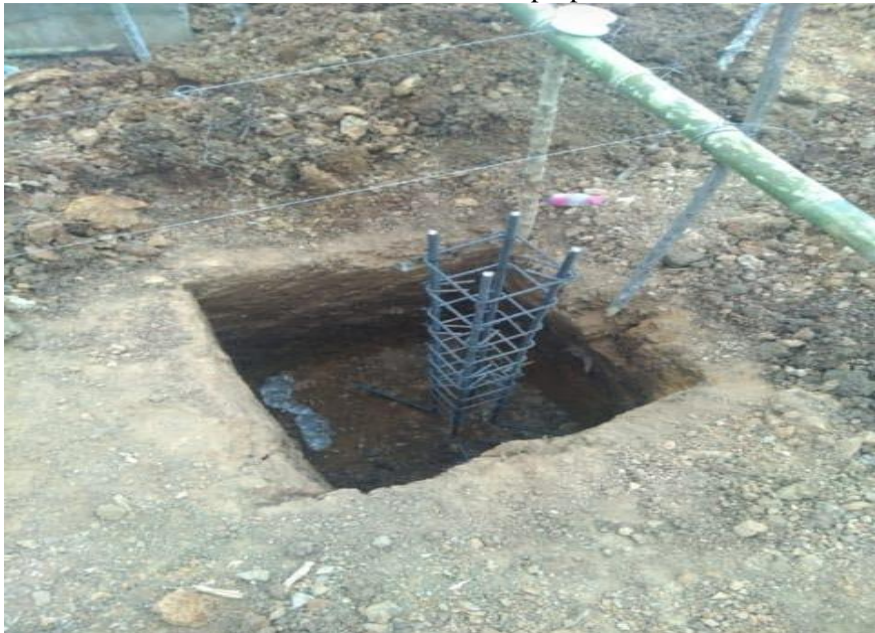
Figura 11: excavación de zapatas
