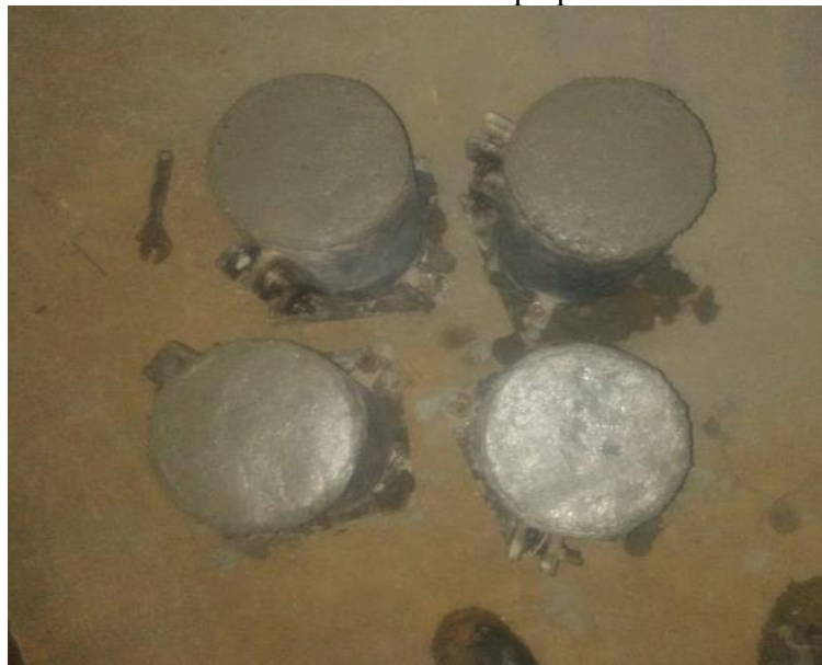
Figura 29. Toma de muestra de concreto para ensayo de Resistencia a la Compresión
