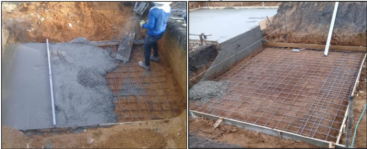
Figura 33. Fundición de losas flotantes de soporte PTAR SAN CRISTOBAL
