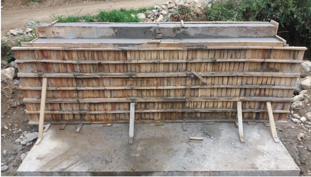
Imagen 41. Estribo fundido - Pontón Gualpí.
