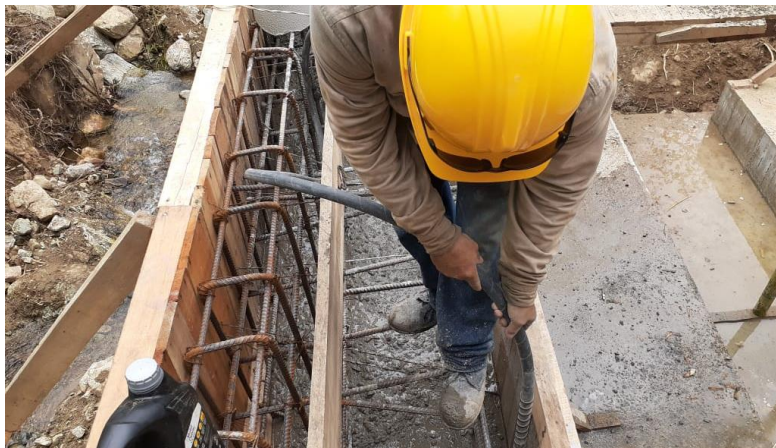
Imagen 40. Vibrado de estribo - Pontón Gualpí.
