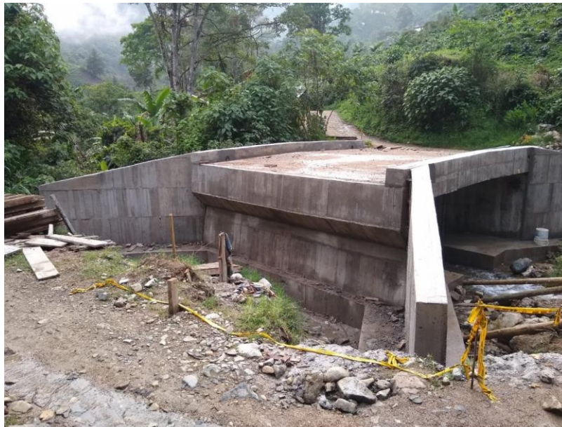
Imagen 30. Obras de arte terminadas - Pontón La Mina.
