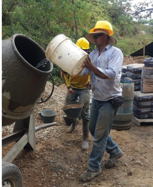
Imagen 8. Preparación de concreto en sitio
