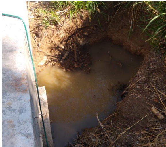
Imagen 44. Excavaciones aletas - Pontón Gualpí.
