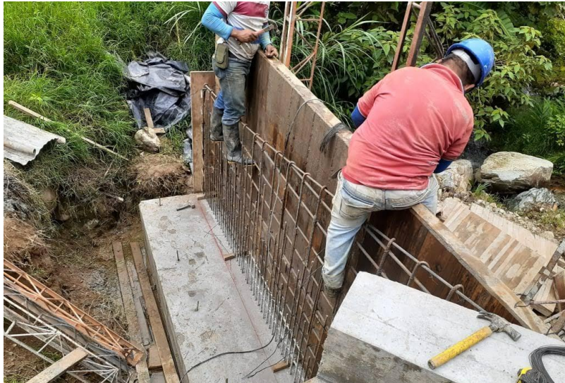
Imagen 27. Fundición brazo de aletas - Pontón La Mina.
