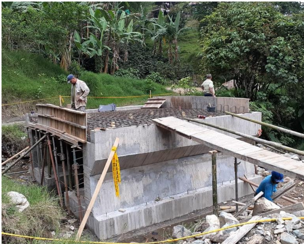
Imagen 20. Armado y figurado de refuerzo de losa - Pontón La Mina.
