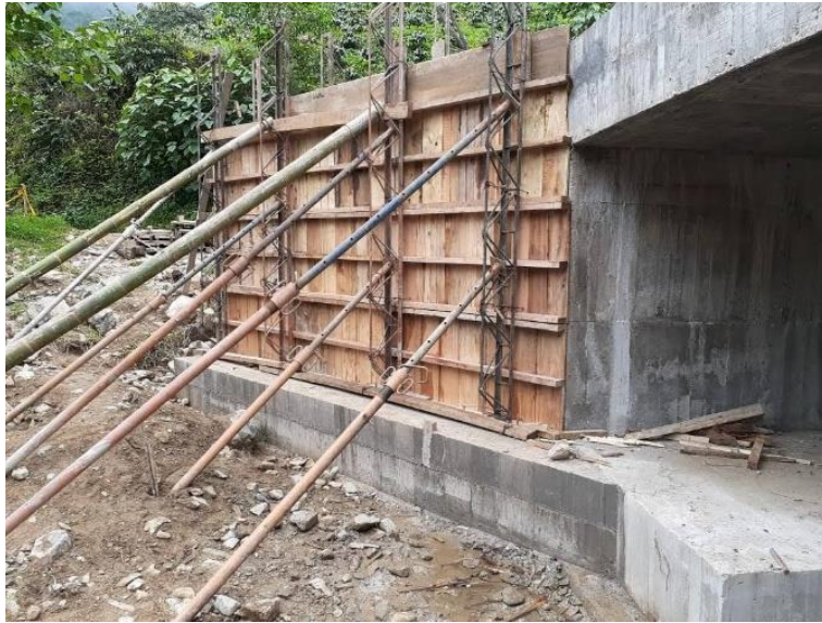
Imagen 2. Camillas apuntaladas con cerchas y parales metálicos
