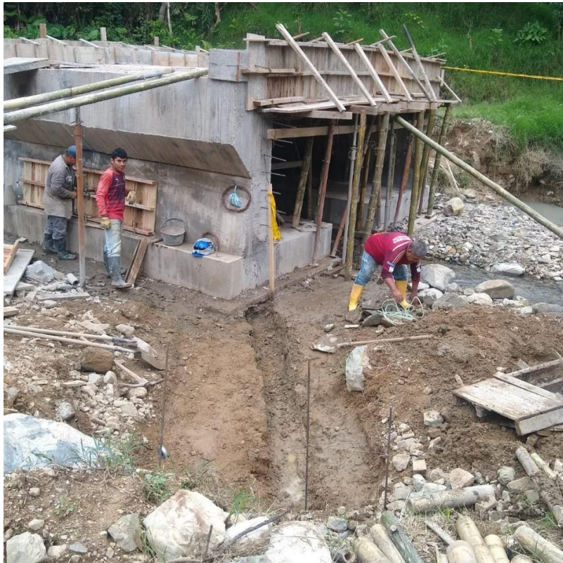
Imagen 23. Excavaciones de las aletas - Pontón La Mina.
