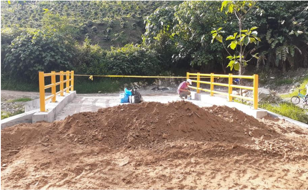
Imagen 32. Llenos con material seleccionado - Pontón La Mina.
