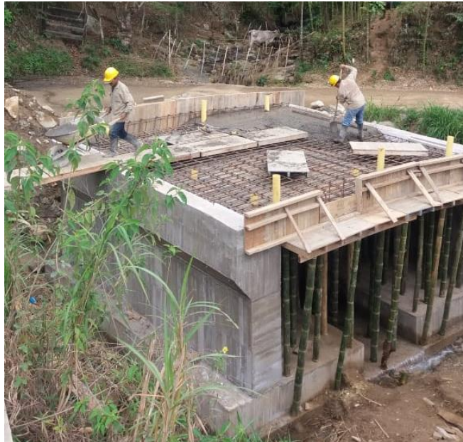
Imagen 43. Fundición de losa - Pontón Gualpí.
