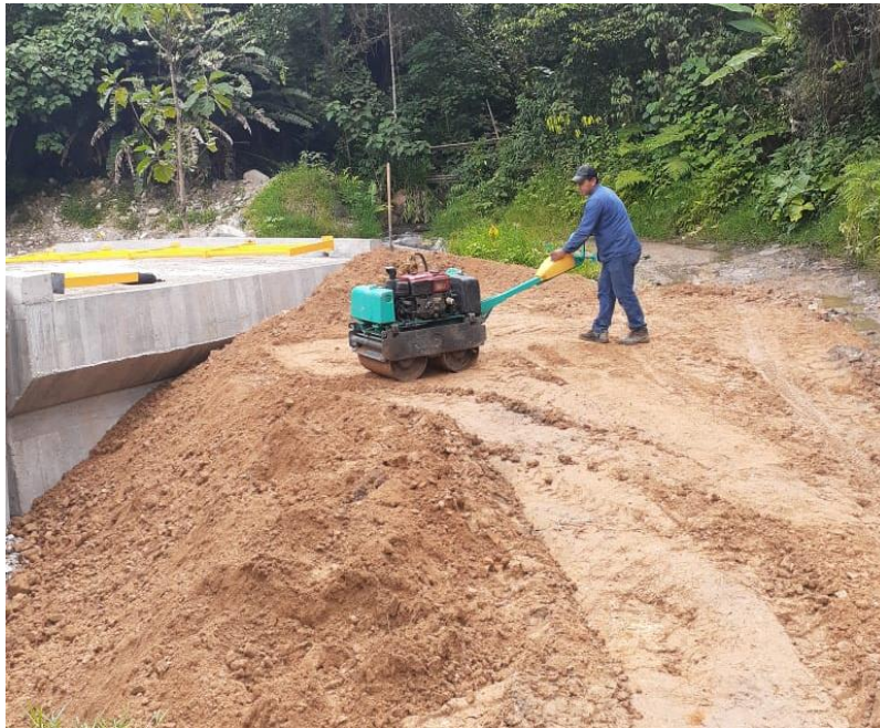
Imagen 5. Vibro compactador en operación
