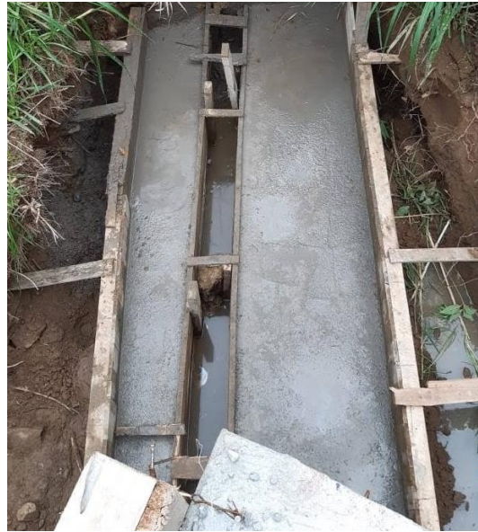
Imagen 24. Muertos en concreto ciclópeo - Pontón La Mina
