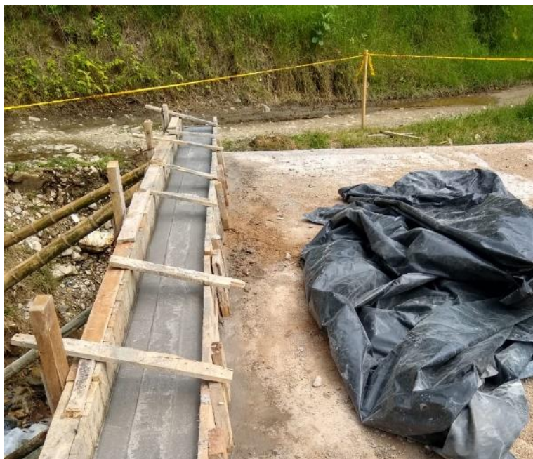
Imagen 22. Bordillo o guarda rueda - Pontón La Mina
