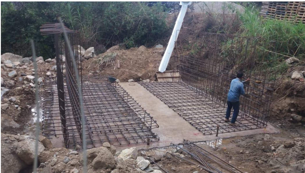
Imagen 36. Solados de concreto pobre - Pontón Gualpí.
