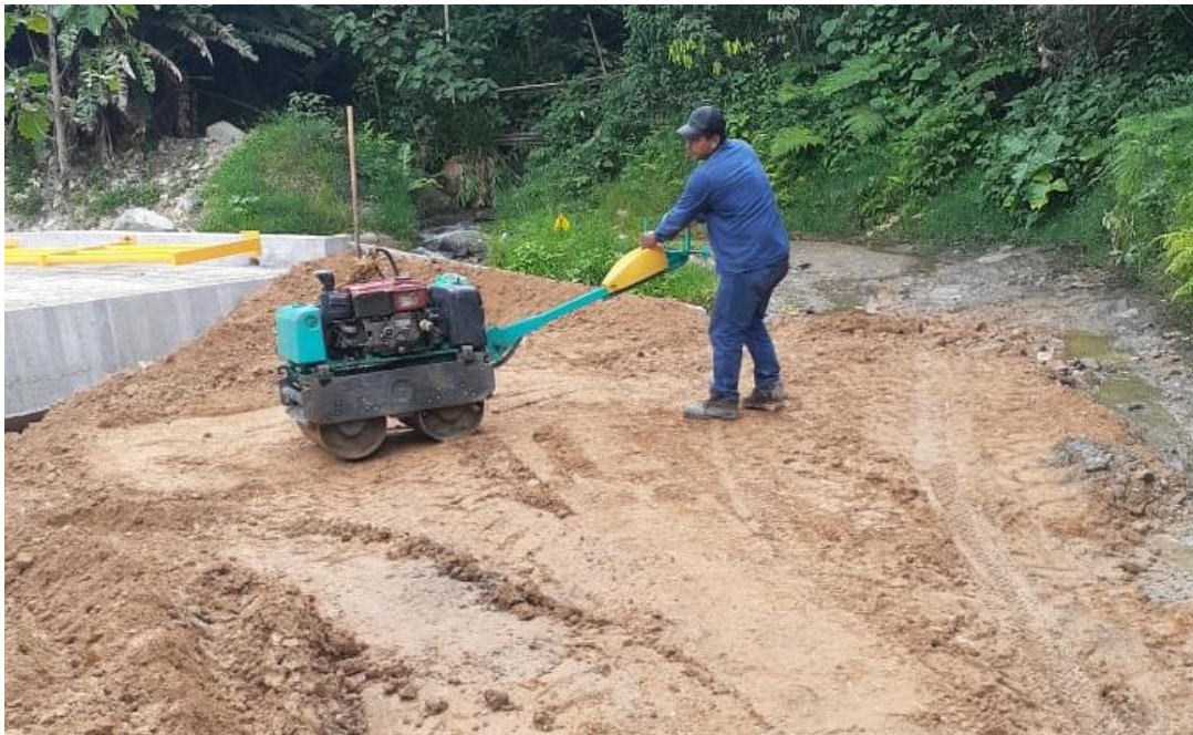
Imagen 33. Conformación de la Calzada - Pontón La Mina.
