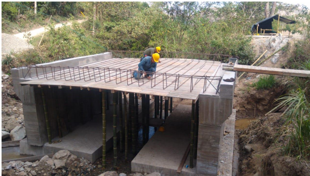
Imagen 42. Armado de acero de refuerzo losa - Pontón Gualpí.
