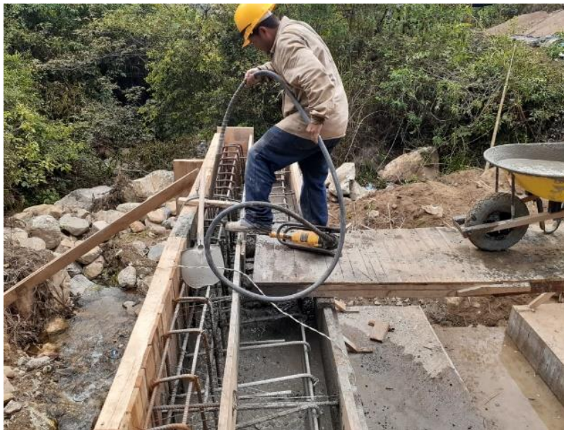
Imagen 4. Vibrado de concreto de estribo
