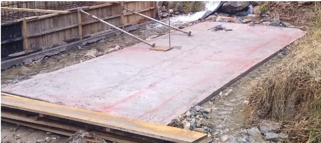
Imagen 15. Solados de concreto – Pontón La Mina.
