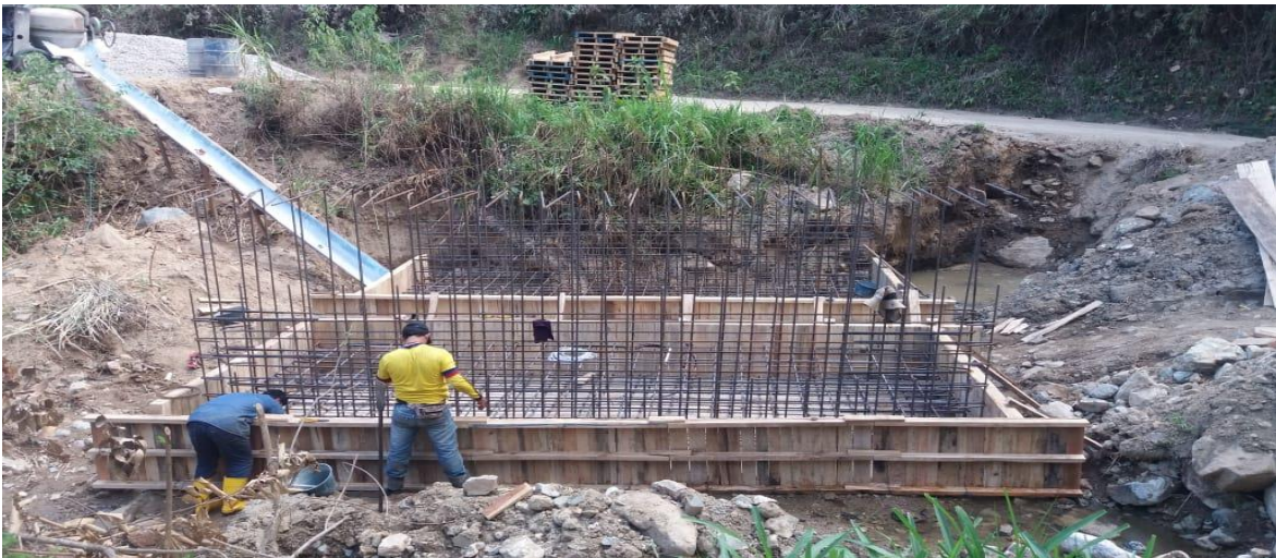
Imagen 16. Figurado de acero de zapatas – Pontón La Mina.
