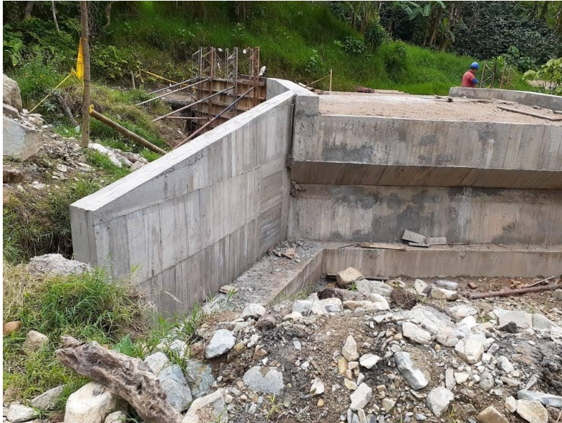
Imagen 29. Aleta fundida y terminada - Pontón La Mina.
