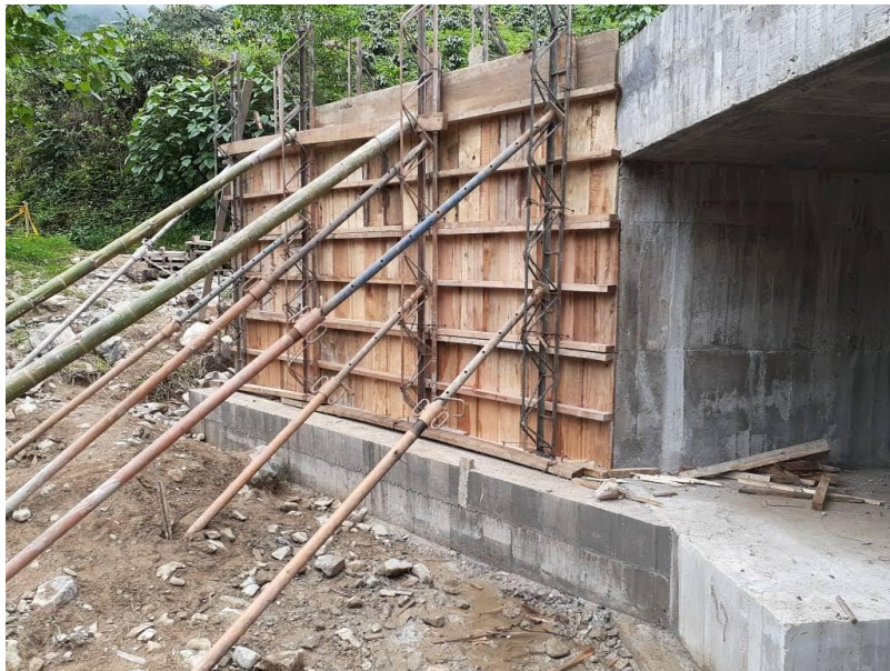
Imagen 28. Brazo de aleta Formaleteado - Pontón La Mina.
