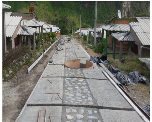
Imagen 31 Placa huella en construcción.
