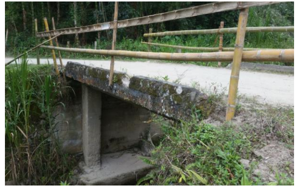
Imagen 36 Puente a restaurar.
