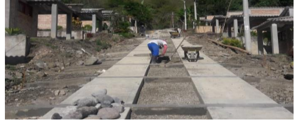
Imagen 16 Obra al 50% ejecutada.
