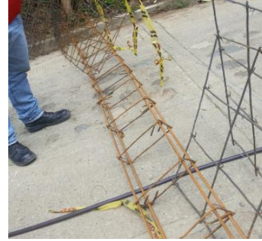
Imagen 23 Acero viga riostra
