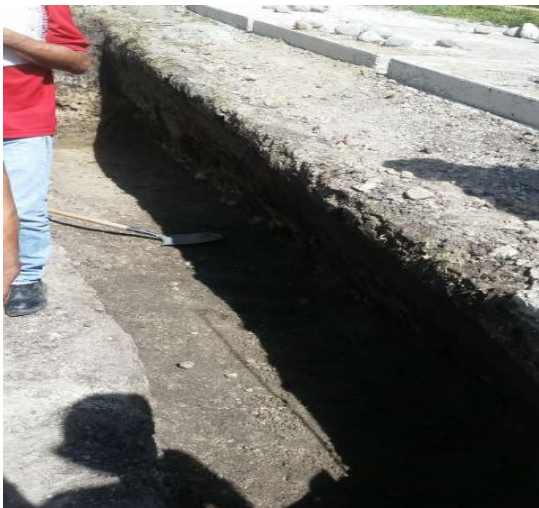
Imagen 30 Excavación muro de contención.
