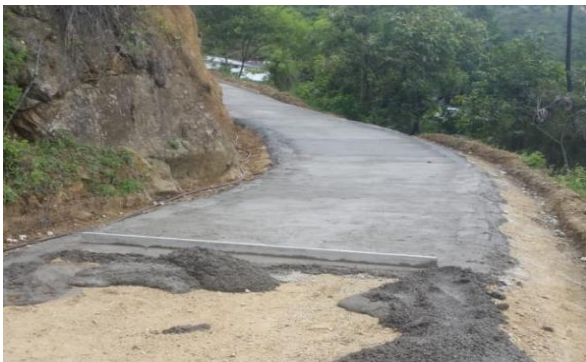
Imagen 24 Concreto de Solado
