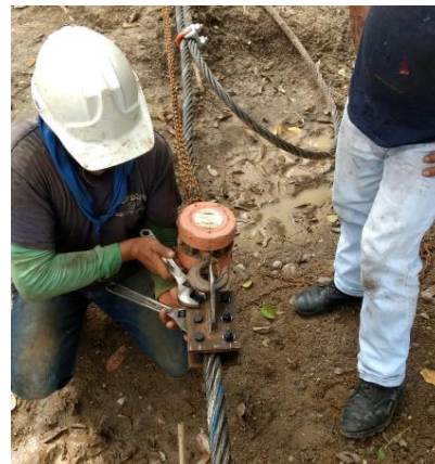
Imagen 46 Tensado de los cables.
