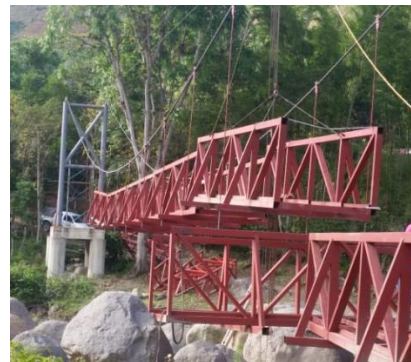
Imagen 48 Instalación de la estructura.
