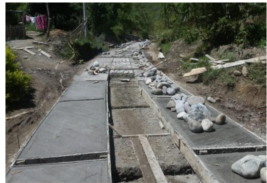
Imagen 25 Fundición Losas.
