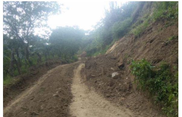
Imagen 38 Derrumbes en la zona.
