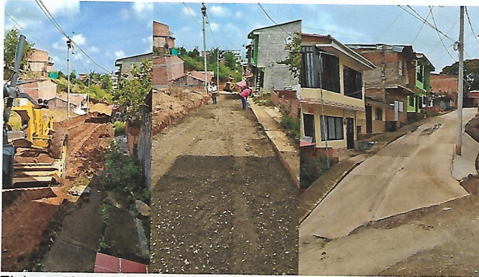
Figura 59. Intervención y terminación carrera 16A sur entre calles 6 y 7.
