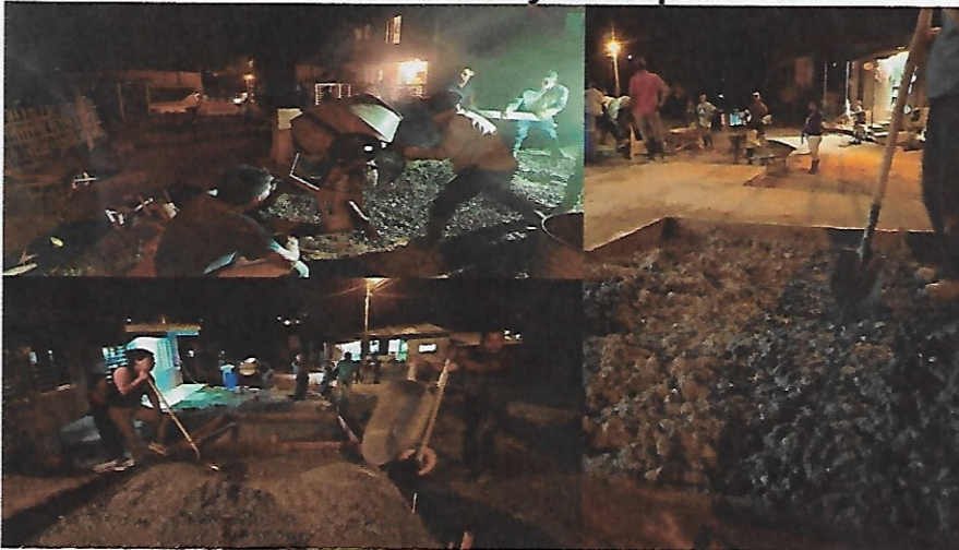
Figura 7. Elaboración de la mezcla y fundición de las losas Carrera 13B Sur entre calles 6A y Principal
