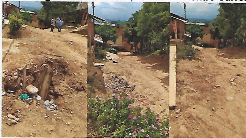
Figura 14. Visita Diagnostico Porvenir, Calle 4 Sur entre Carreras 18 y 18A
