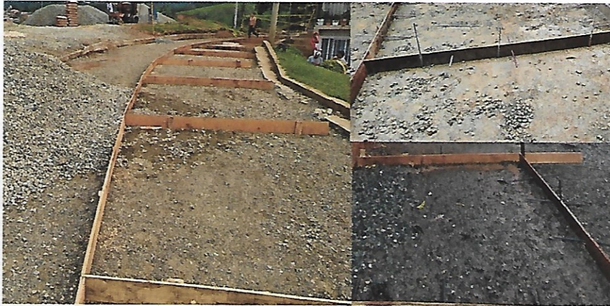
Figura 45. Armado de Formaletas, colocación y engrasado de pasadores
