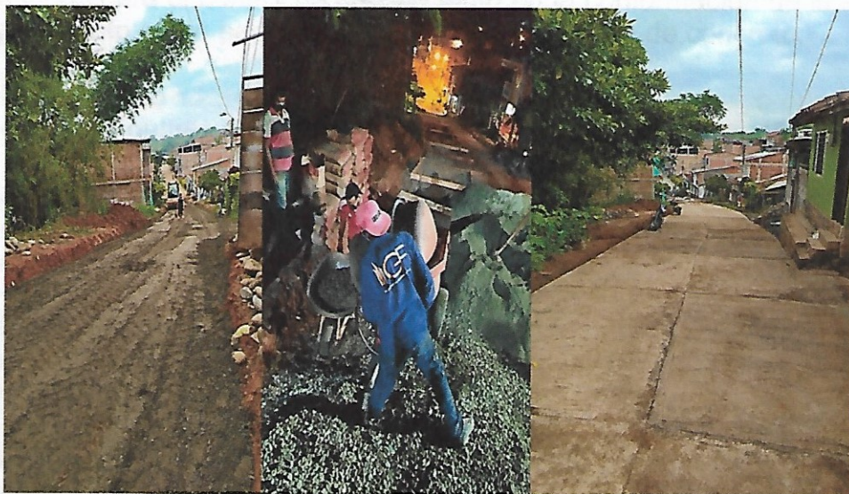
Figura 58. Intervención y terminación carrera 12 sur entre calles 3 y 4.
