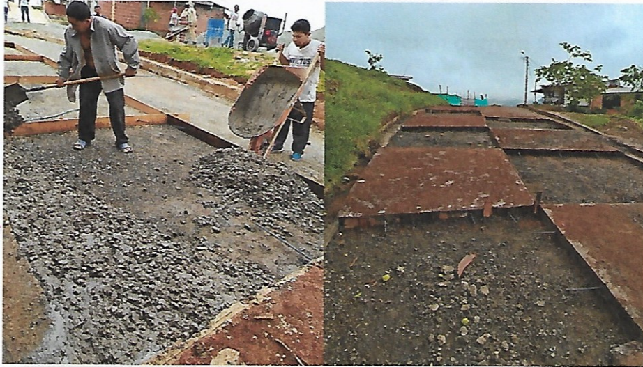
Figura 47. Fundición y curado de las losas de concreto.
