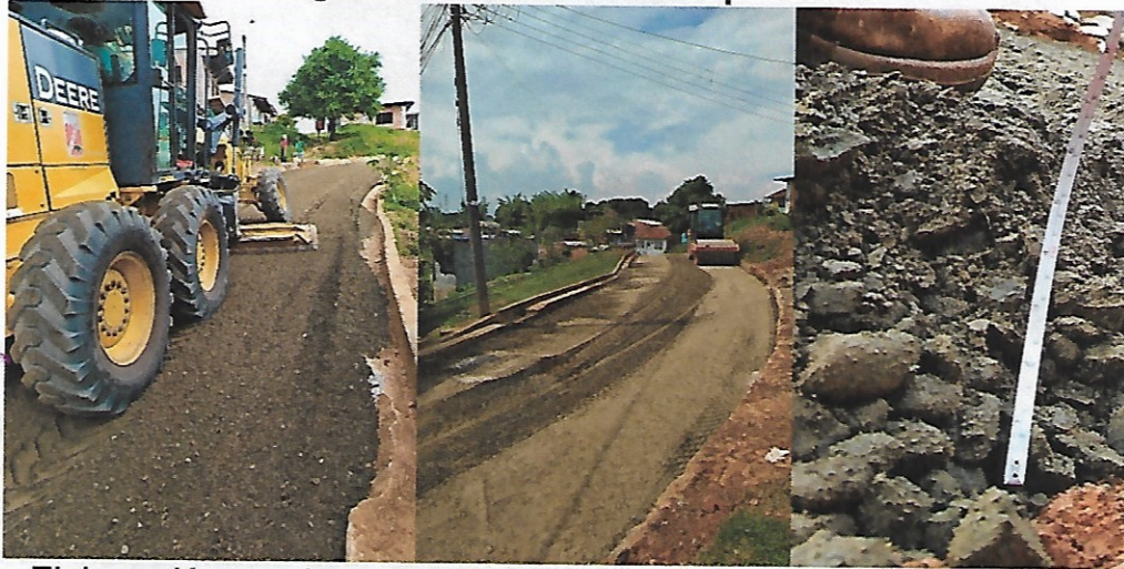
Figura 44. Conformación y compactación de la capa de base granular de 10 cm de espesor.
