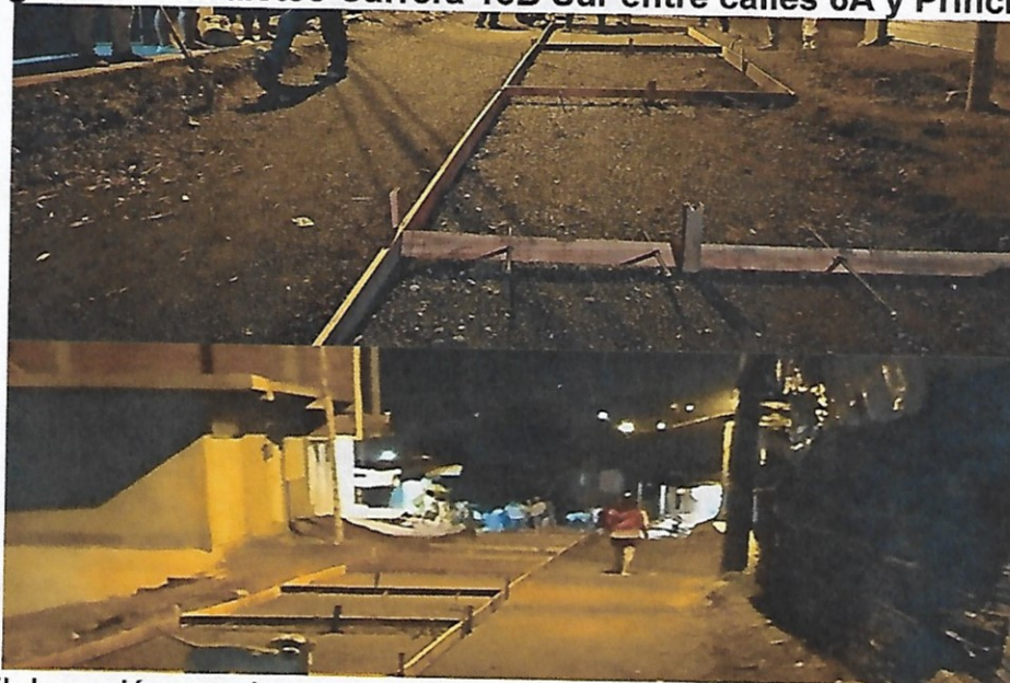
Figura 5. Formaleteo Carrera 13B Sur entre calles 6A y Principal
