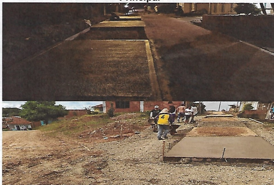
Figura 9. Curado del concreto de las losas Carrera 13B Sur entre calles 6A y Principal
