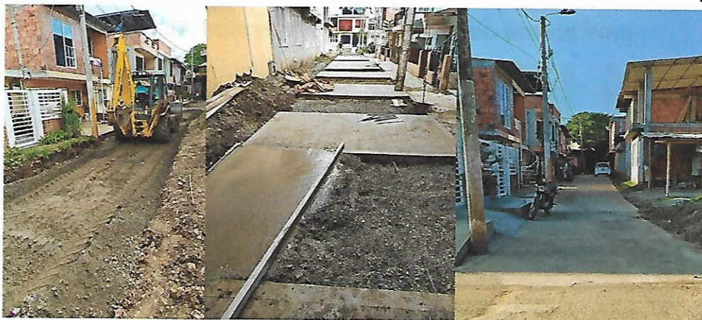
Figura 55. Intervención y terminación carrera 11C entre calles 19 y 20
