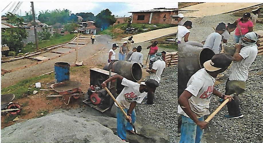
Figura 46. Elaboración de la mezcla de concreto.
