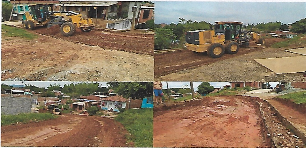
Figura 42. Cajeo vía principal del barrio la esperanza
