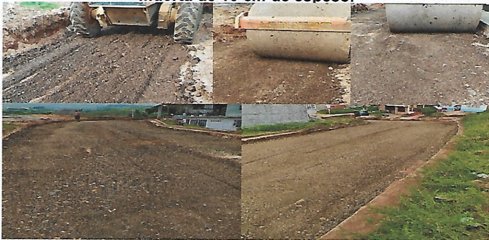
Figura 43. Conformación y compactación de capa de roca muerta de 10 cm de espesor
