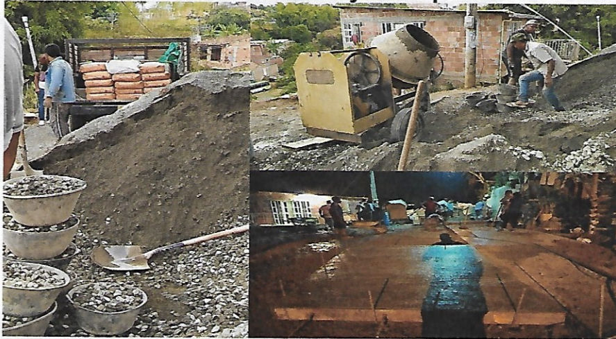
Figura 6. Elaboración de la mezcla y fundición de las losas Calle 6B entre carreras 13C Sur y Principal
