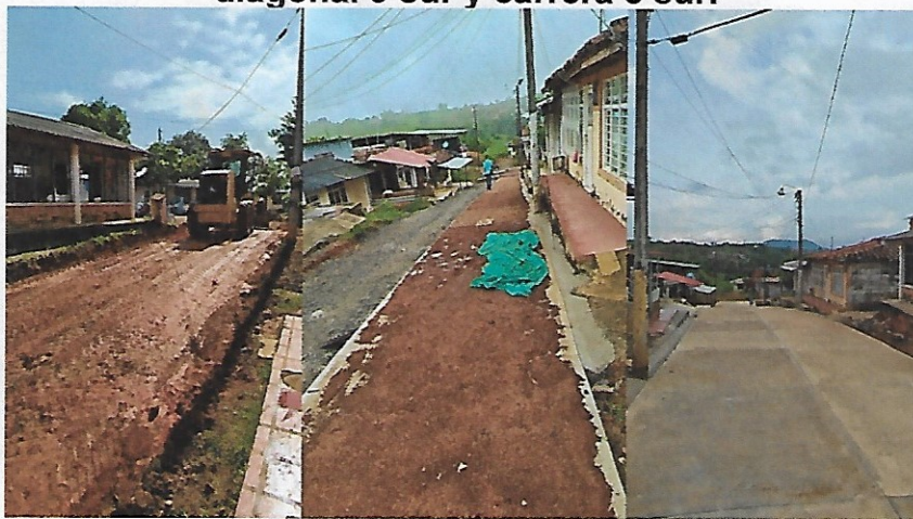
Figura 50. Intervención y terminación calle 10 sur entre diagonal 9 sur y carrera 8 sur.
