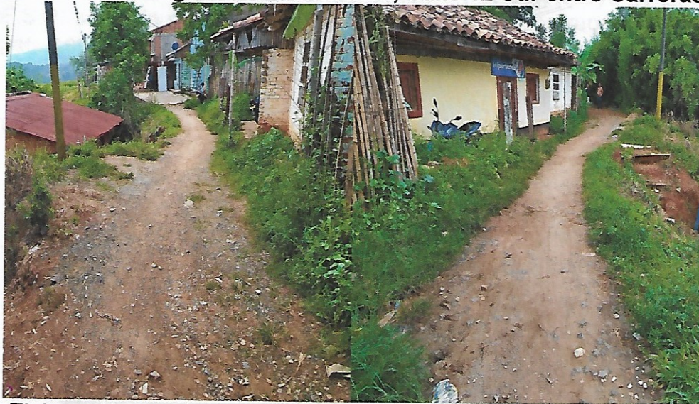
Figura 11. Visita Diagnostico Santa Inés, Calle 12 Sur entre Carreras 2 y 3
