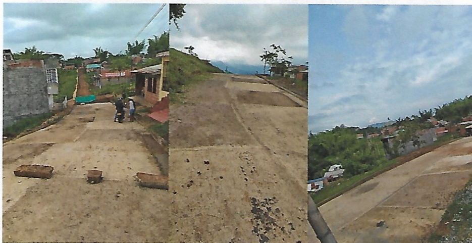
Figura 48. Vía principal barrio La Esperanza terminada.
