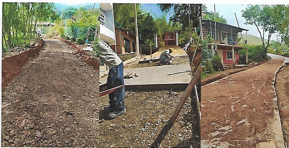
Figura 52. Intervención y terminación sector llanito.
