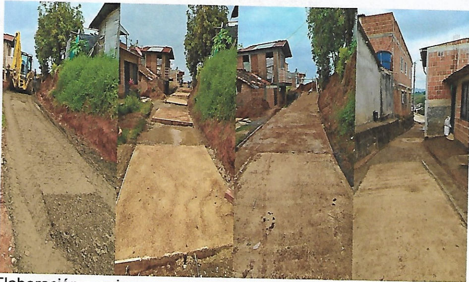
Figura 53. Intervención y terminación carrera 13C sur entre calles 6 y 7 sur.
