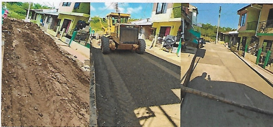
Figura 56. Intervención y terminación calle 20A entre carreras 12 y 12A.
