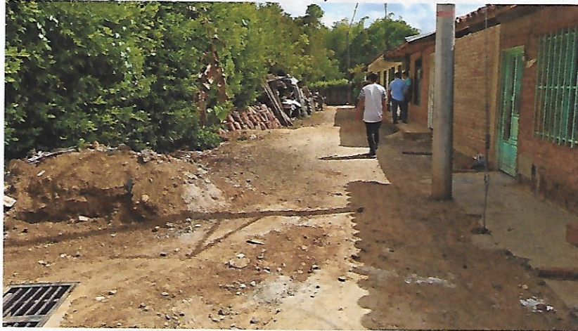
Figura 13. Visita Diagnostico Santa Inés, Carrera 11A Sur entre Calles 4 y 5
