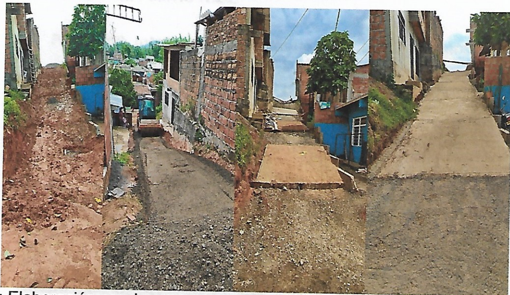
Figura 54. Intervención y terminación calle 6A sur entre carreras 13B y 13C sur.
