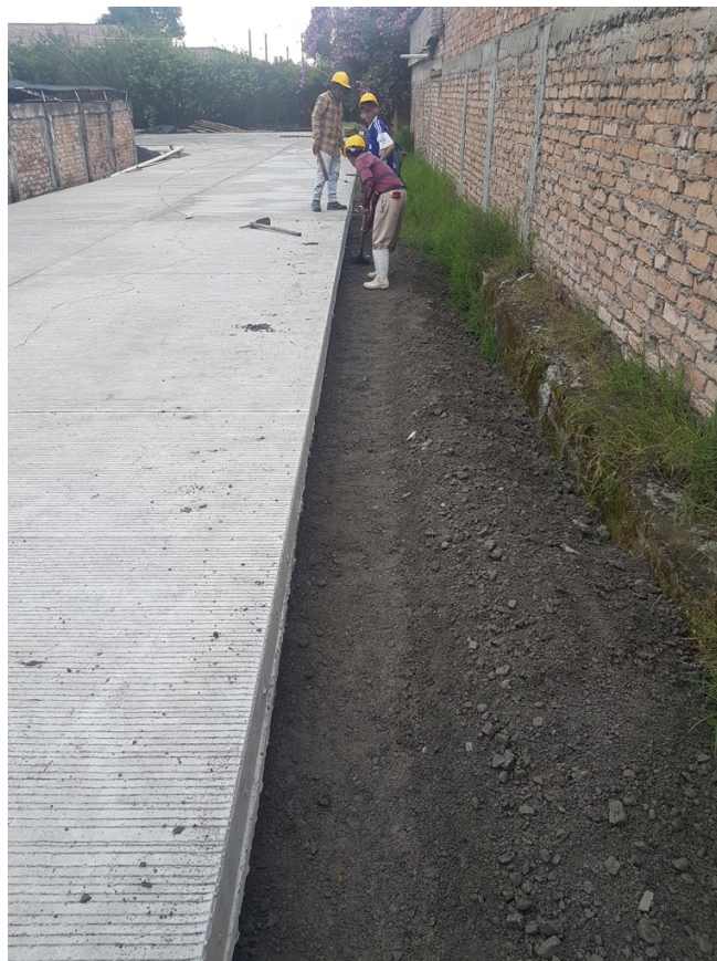
Figura 22. Adecuación del terreno para la instalación del bordillo
