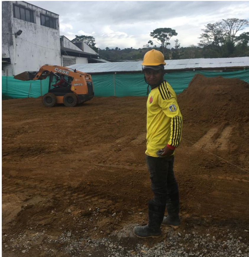
Figura 27. Relleno con tierra amarilla en zona de descargue
