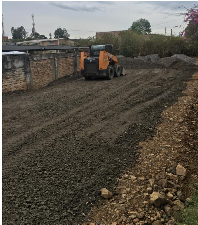
Figura 16. Riego de material de sub base
