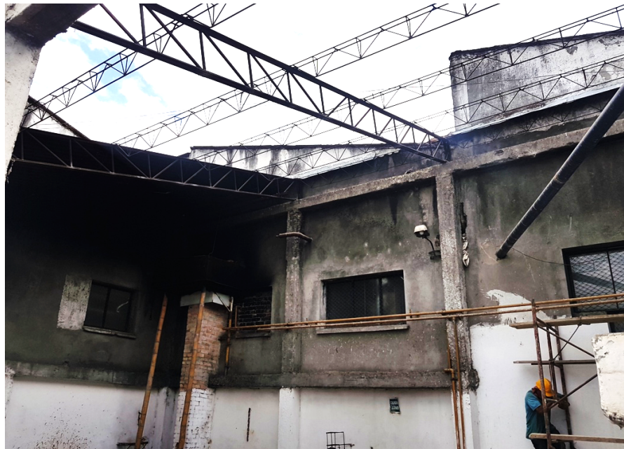
Figura 41. Retiro de cubierta
