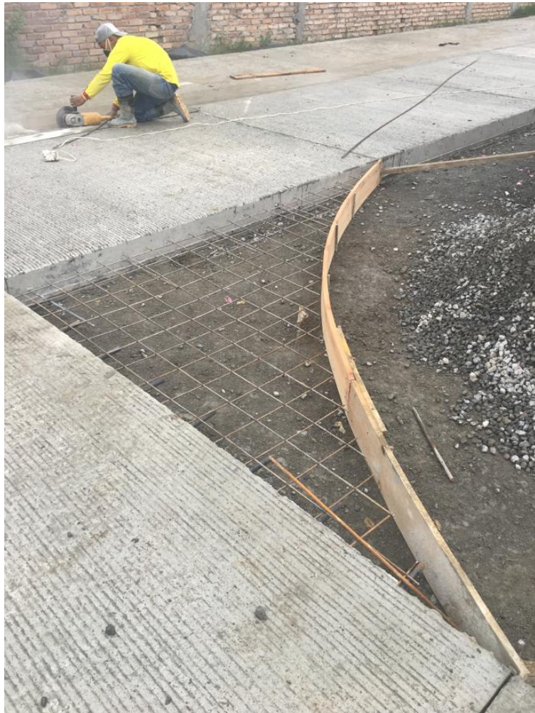
Figura 18. Refuerzo del pavimento al interior de la curva
