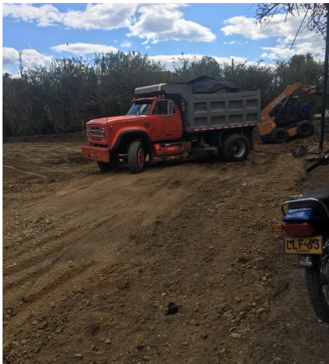
Figura 3. Cargue de material sobrante de excavación
