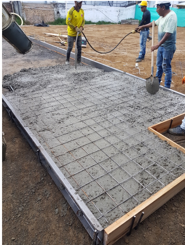
Figura 19. Refuerzo del pavimento alrededor del sumidero
