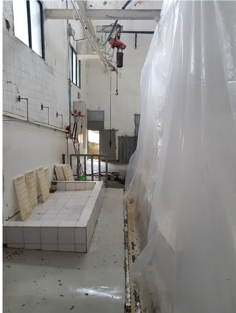
Figura 45. Muro protegido con plástico después de la aplicación de productos Sika
