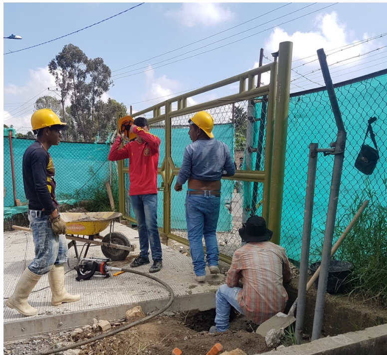
Figura 26. Cerramiento de la planta de porcinos
