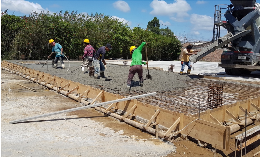
Figura 33. Fundición de losa de zona de descargue
