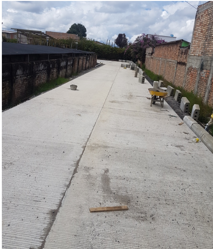
Figura 23. Pavimento rígido terminado
