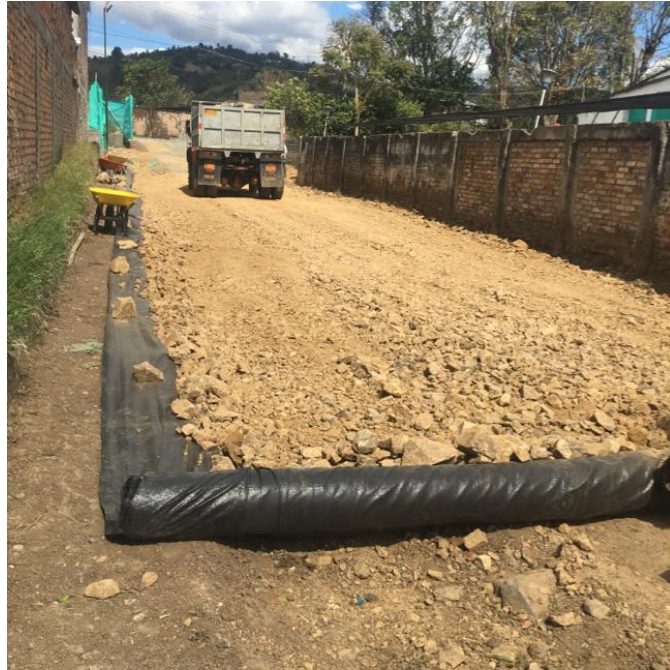
Figura 7. Instalación de geotextil
