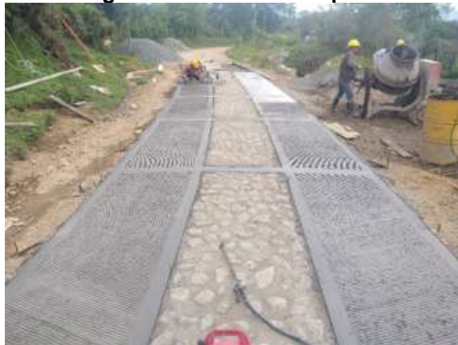
Figura 35 Fundición de placa
