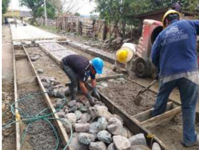
Figura 13 Fundición de piedra o concreto ciclópeo
