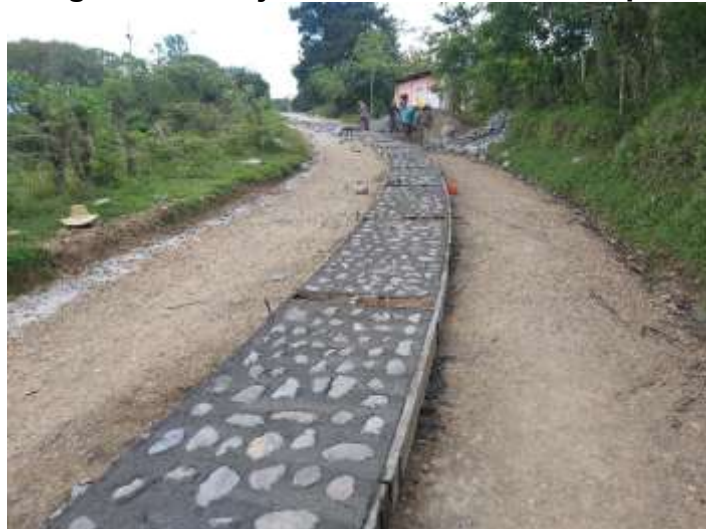
Figura 32 Franja central concreto ciclópeo
