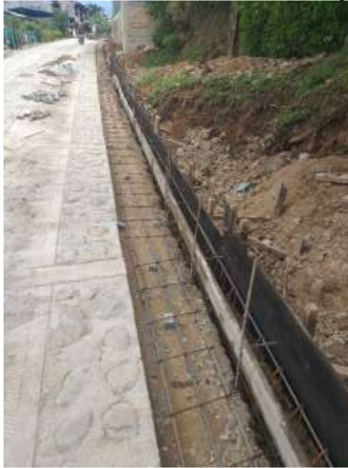
Figura 25 Acero de refuerzo de cuneta y bordillo
