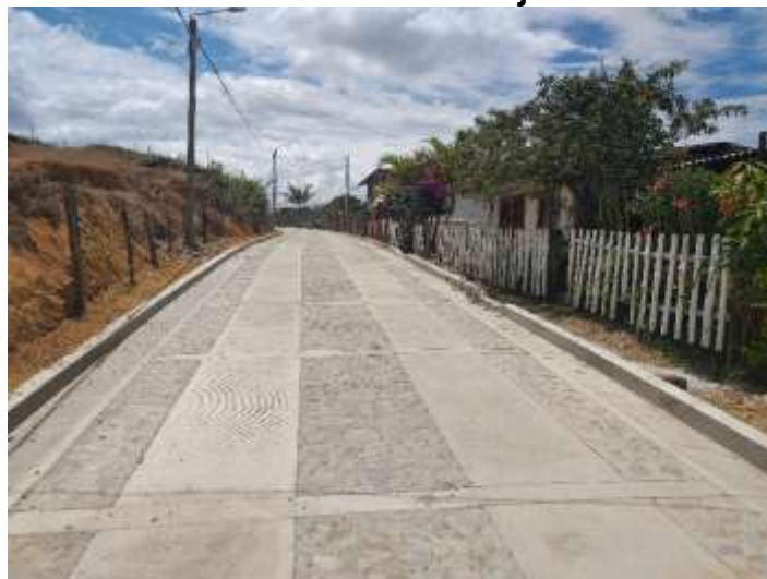
Figura 29 Obra finalizada Vereda Cajete sector La Mulata
