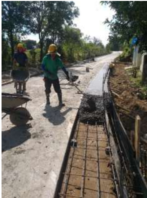
Figura 36 Fundición cuneta y bordillo
