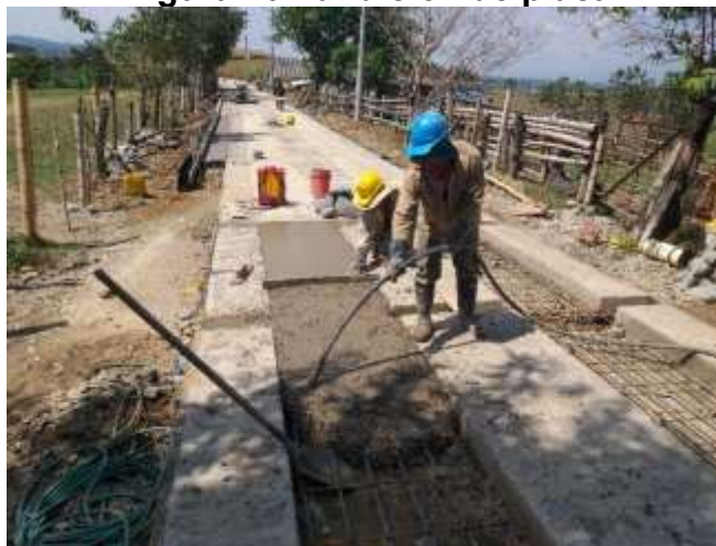
Figura 20 Fundición de placa
