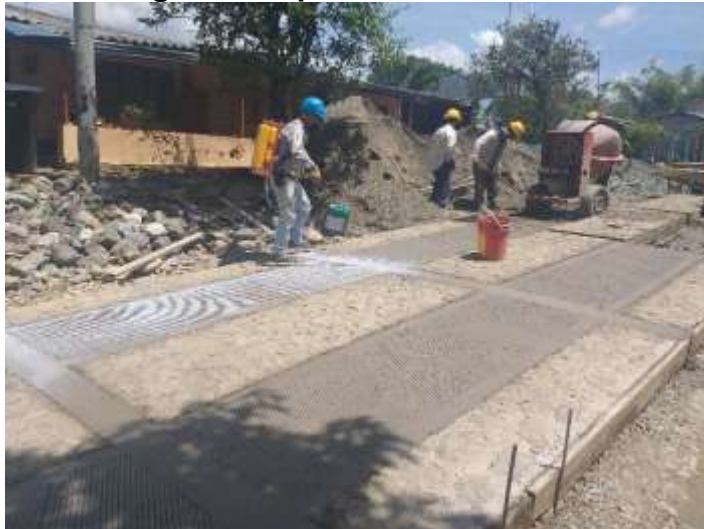
Figura 23 Aplicación de antisol
