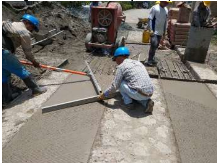
Figura 21 Acabado en espina de pescado
