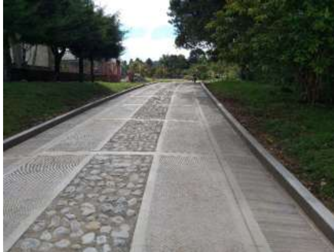
Figura 37 Obra finalizada Vereda Santa Bárbara
