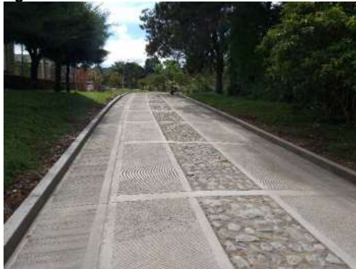
Figura 38 Obra finalizada Vereda Santa Bárbara
