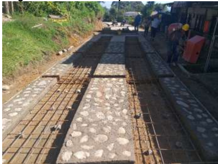
Figura 19 Mallas sobre panelas de concreto
