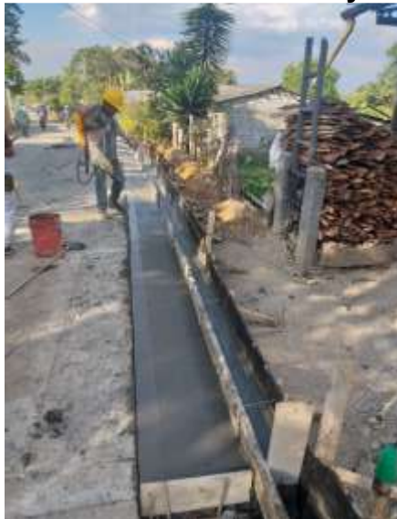
Figura 27 Acabado de cuneta y bordillo
