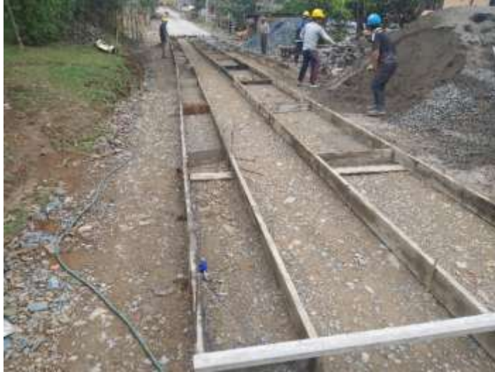
Figura 12 Formaleta para concreto ciclópeo
