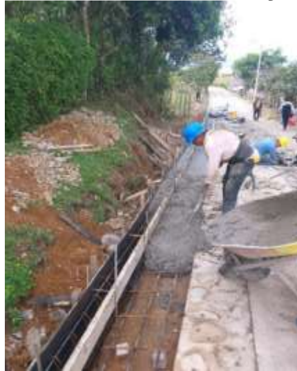
Figura 26 Fundición de cuneta y bordillo
