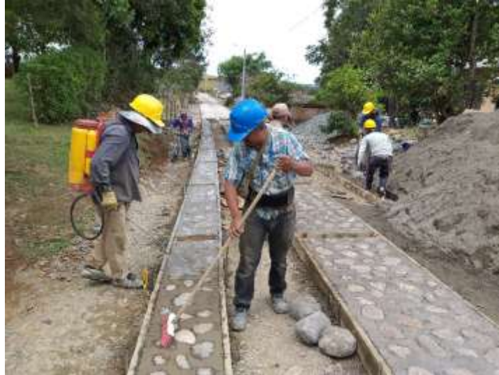
Figura 16 Escobado y aplicación de anti sol
