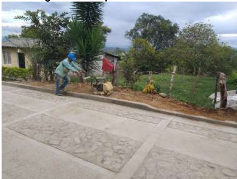
Figura 28 Compactación de rellenos
