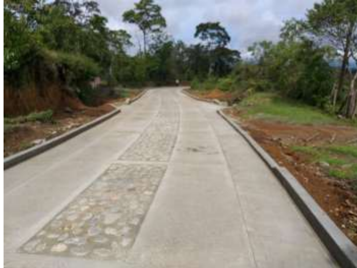
Figura 39 Obra finalizada Vereda Santa Bárbara
