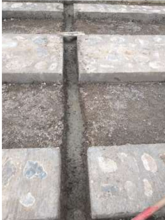
Figura 17 Excavación de riostras y solado
