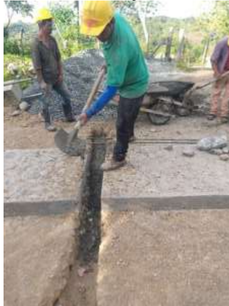
Figura 33 Excavación y solado de riostra
