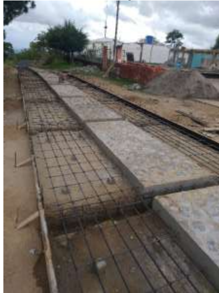
Figura 34 Mallas extendida para fundición de placa
