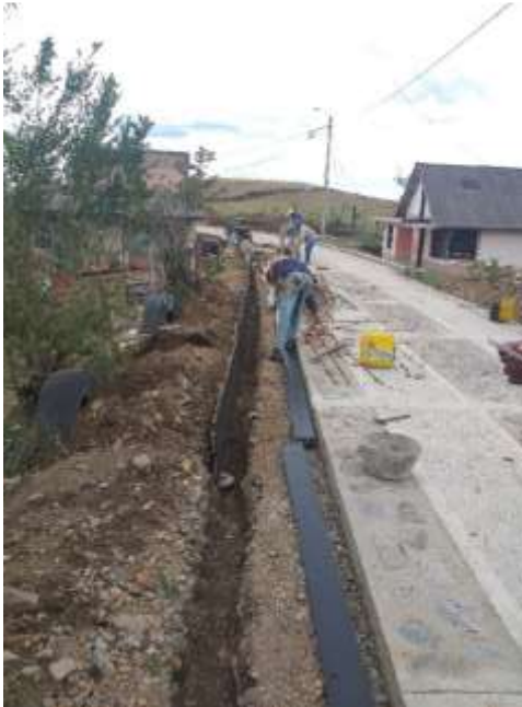
Figura 24 Instalación formaleta de cuneta y bordillo
