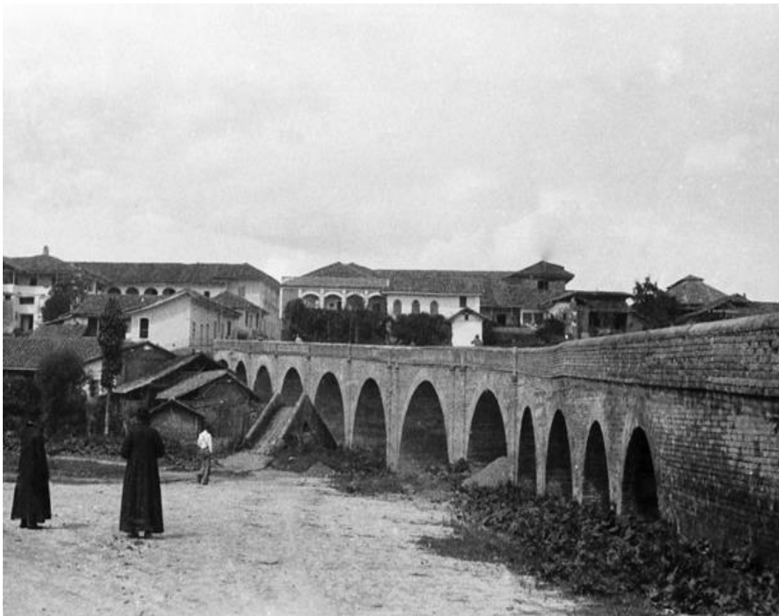
El Puente del Humilladero, que con sus dos arcos cruza el río Molino, es una construcción de mampostería levantada en 1873 por Fray Serafín Barbetti.
