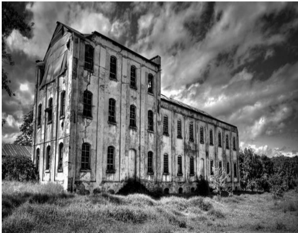
Molino Moscopán en estado de deterioro
