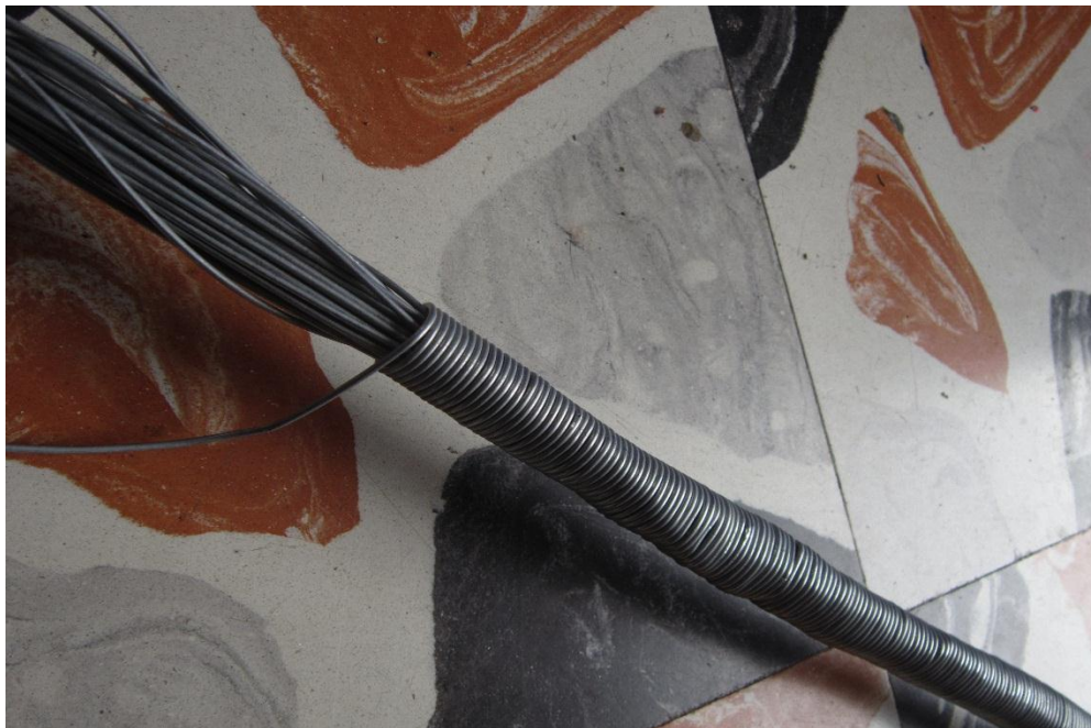
Ilustración 16. Alambre material para obra en proceso. José Euclides Piamba. Fotografía 2015
