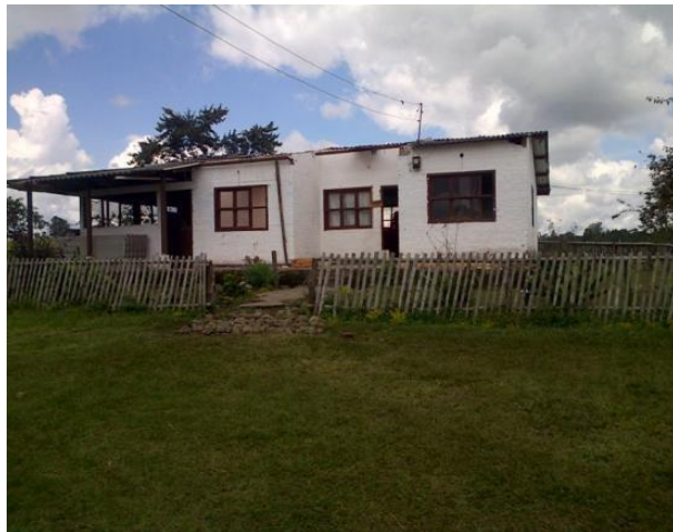
Casa principal de la escuela. Manos a la obra de recuperación Tomada por
