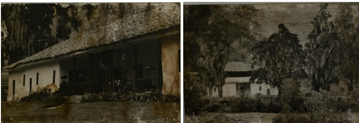
Imágenes 9 y 10. Fotografías del siglo XX de la hacienda de Coconuco. Autor desconocido, fotos encontradas dentro de la casa principal de la hacienda.
