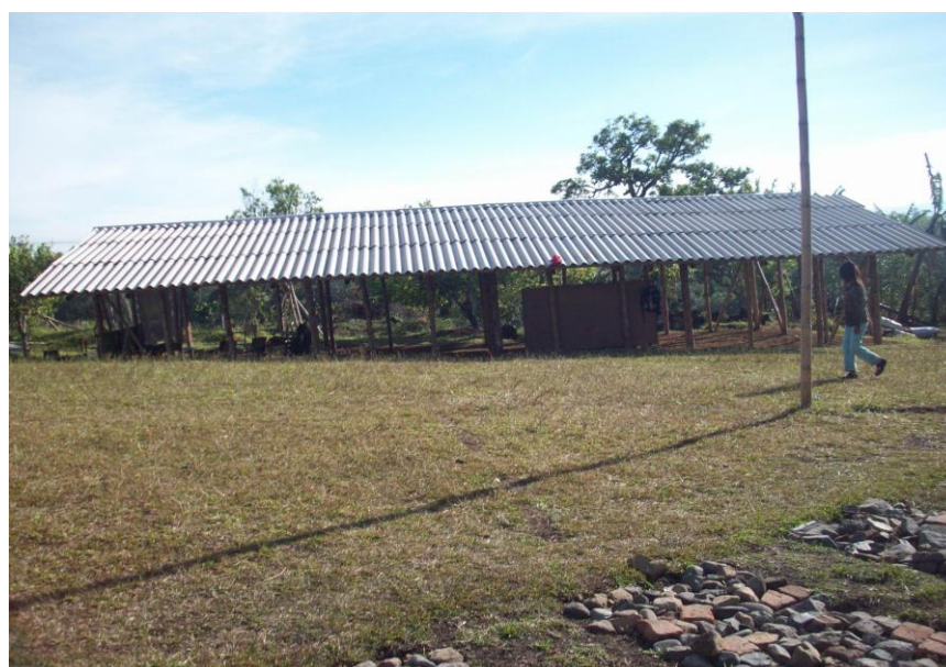
Foto No.7: Construcción nueva en guadua para atender a los niños de los grados tercero, cuarto y quinto. Fuente: Archivo personal, Silva (2013)
