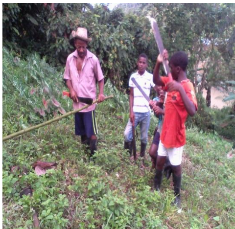
Toma de medida para cortar el material de construcción de la azotea
