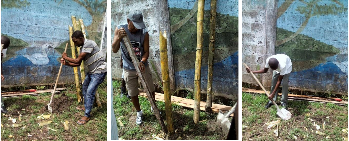
Fotos 38, 39 y 40. Construcción de la azotea. Tomada por Merlyn Paredes, junio de 2016
