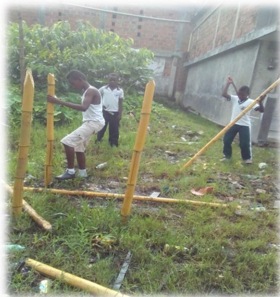
Foto 18. Construcción azotea sus conocimientos. Tomada por Ana Edith Quiñones 2016
