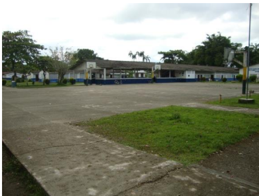
Fotografía 10 estructura física de la Normal Superior
