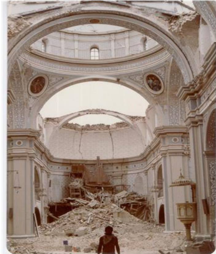
Ilustración 7 La cúpula de la Catedral se desplomó
