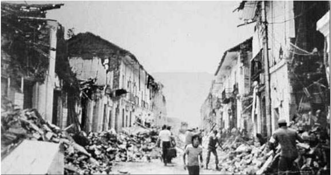
Ilustración 2 Sector histórico de Popayán destruido por el sismo de 1983
