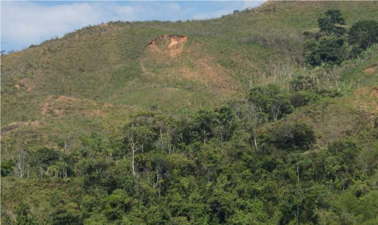
Foto No. 21: Deslizamiento provocado por alta pendiente y deficiencia de coberturas vegetales que facilitan el anclaje de las capas superficiales.
