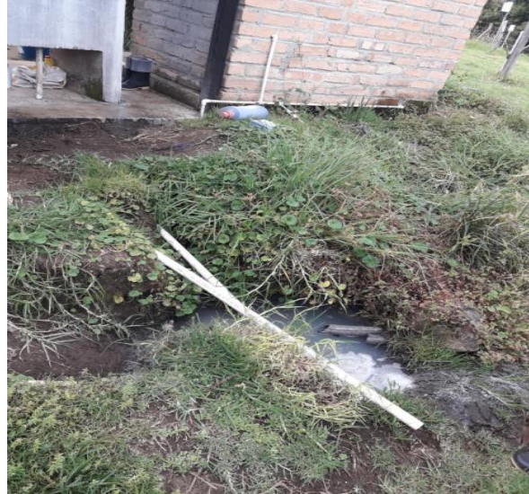
Vertimiento de aguas residuales por parte de viviendas, Fotografía: David Fernando Quiguanás y María Camila Prado, Vereda Santa Elena, Subcuenca Río Molino, junio 2018.
