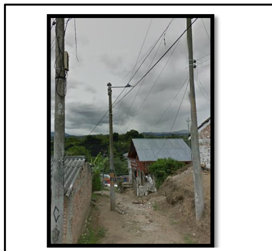
Fotografía 8. Registro Fotográfico condiciones de las vías
