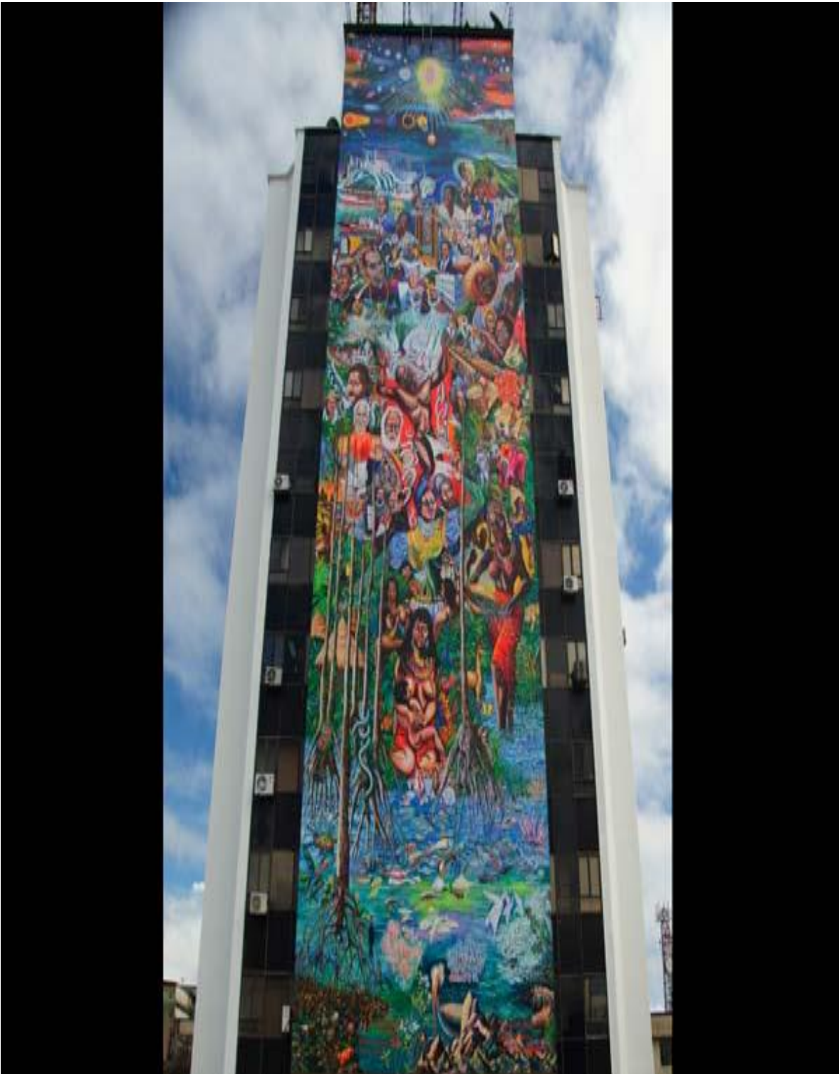
Anexo 6. Vista del edificio de corte mediterráneo de 14 pisos donde se ve un telón que relata el progreso de B/tura
