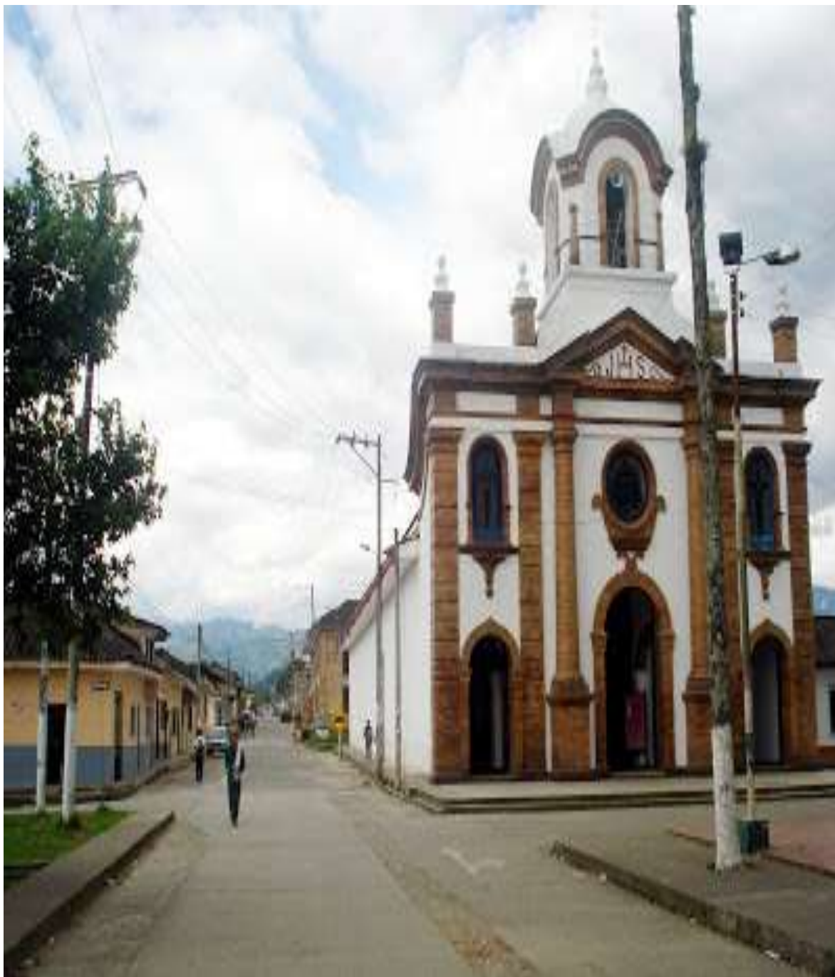
Figura 2. Vista del municipio de Timbío, iglesia San Pedro (Primer iglesia del municipio)
