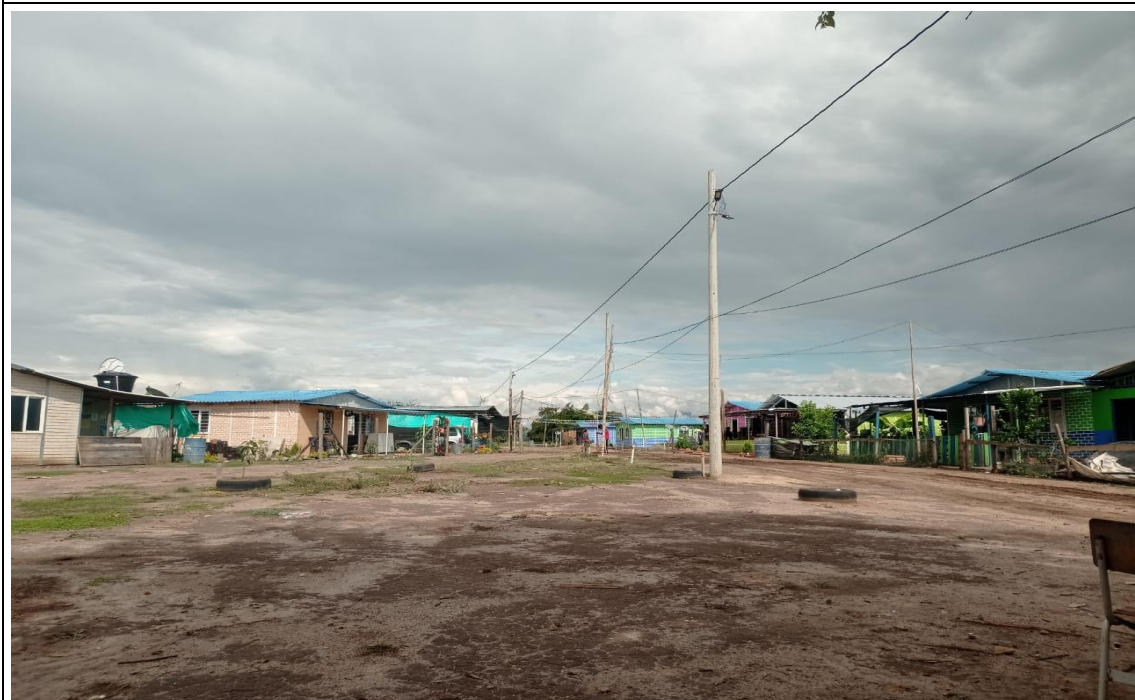
VIVIENDAS CON RED ELÉCTRICA.
