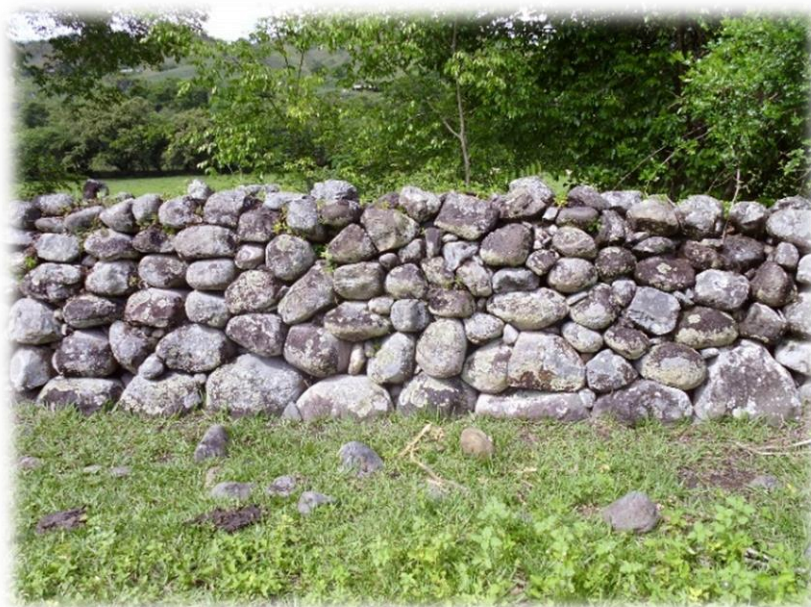
Figura 11: Restos de la muralla ubicada en la parcela que lleva su mismo nombre
