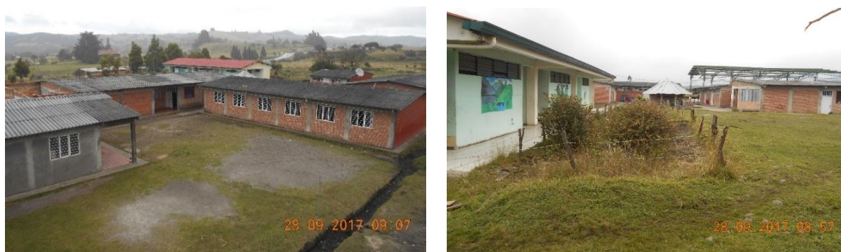
Figura 5- Infraestructura del Colegio Agroindustrial Paletará
