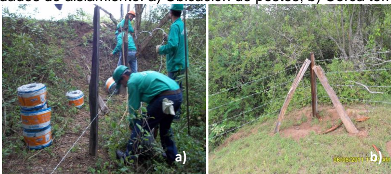
Figura 4. Actividades de aislamiento. a) Ubicación de postes; b) Cerca terminada
