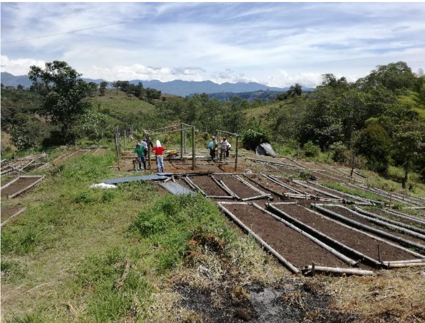
Fotografía 4. Contruccion de compostera
