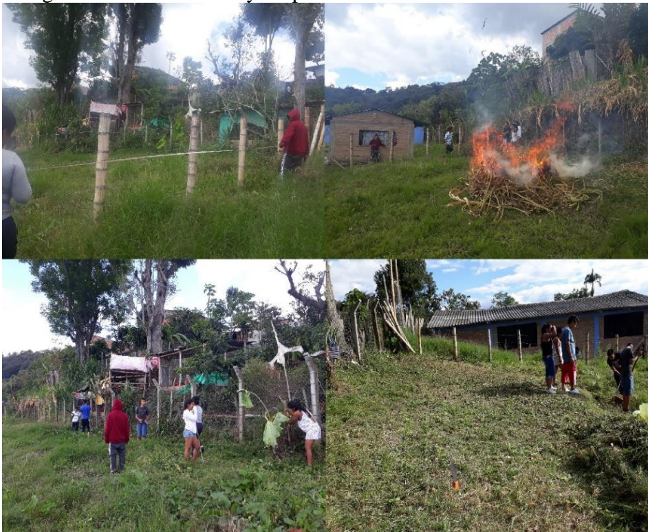
Fotografía N° 9. Desmonte y limpieza del terreno.
