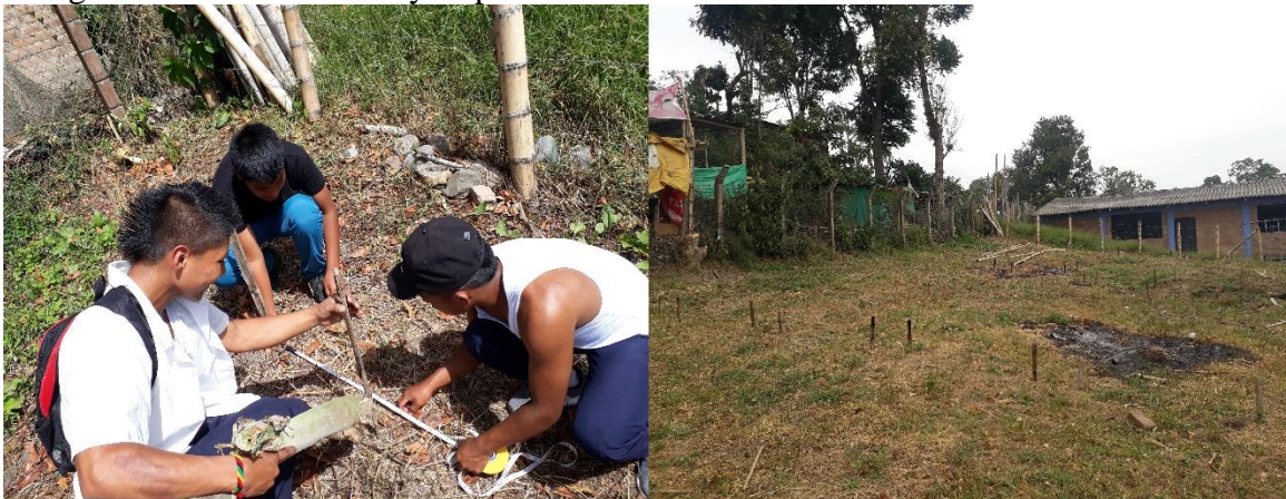
Fotografía N° 10. Medición y Replanteo del terreno.
