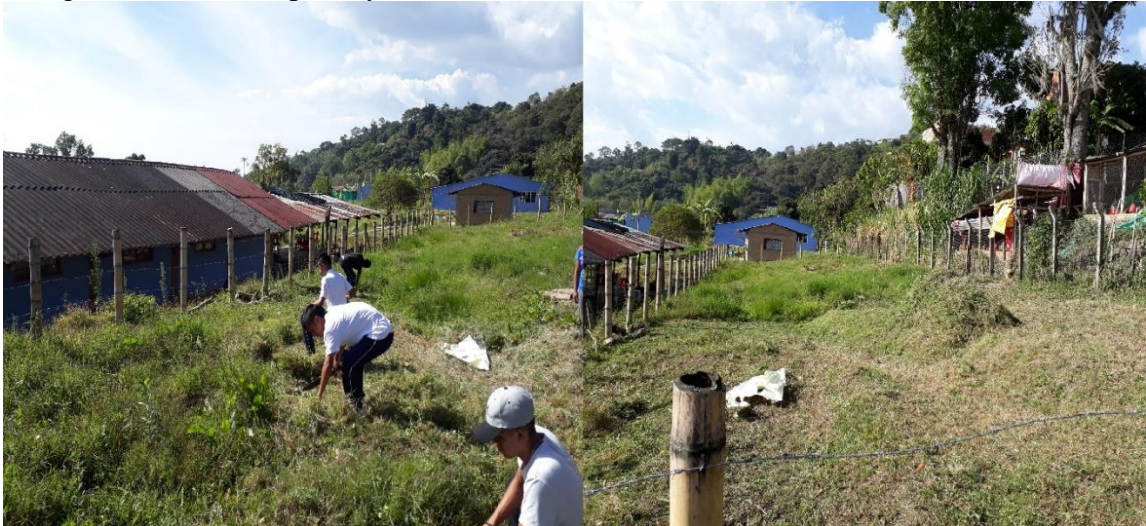
Fotografía N° 31. Limpieza y Desmante del terreno.
