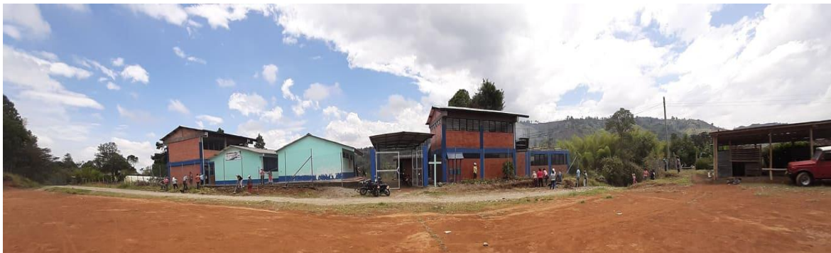
Fotografía 6. Panorámica, Centro Educativo La Laguna, Sede Los Quingos Cancha y caseta de reunión. Fuente propia. 2020
