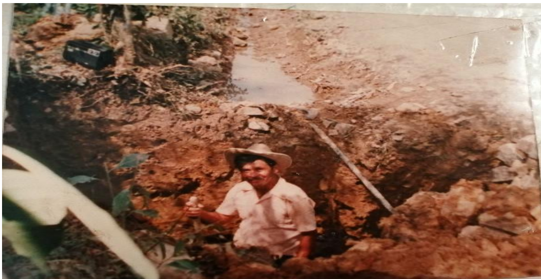
Figura 9 Obrero realizando la instalación de la energía. Fuente familiar.
