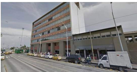
Ilustración 4 Caracterización de la Malla Vial Carrera 46
