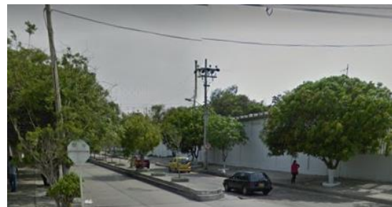
Ilustración 6 Caracterización De La Malla Vial Calle 58.
