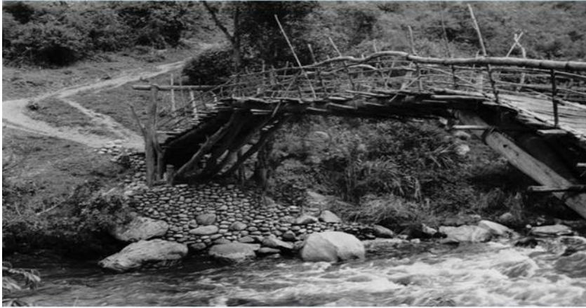
Fotografía 12. Puentes sobre el río Páez en el Resguardo Indígena de Tálaga
