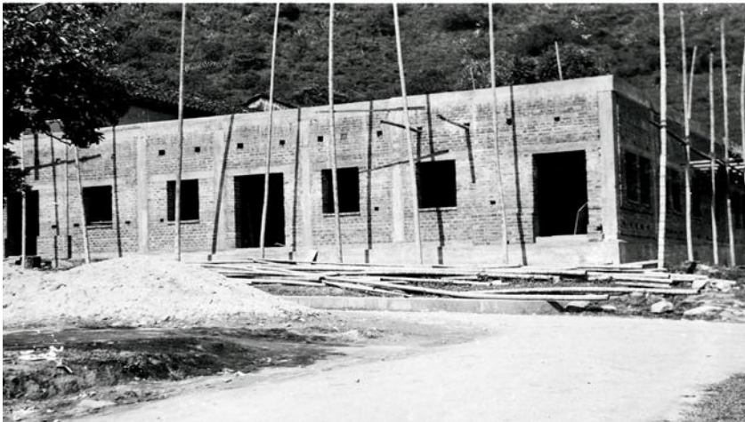
Fotografía 9. Se inicia la construcción de la casa cural
