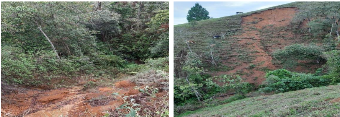
Figura 17. Deslizamientos parte alta quebrada los vivos.
