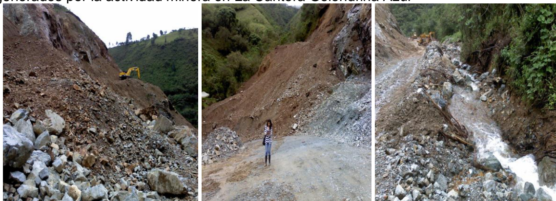
Figura 7. Afectación sobre la quebrada La Honda, Municipio de Puracé, impactos generados por la actividad minera en La Cantera Golondrina Azul
